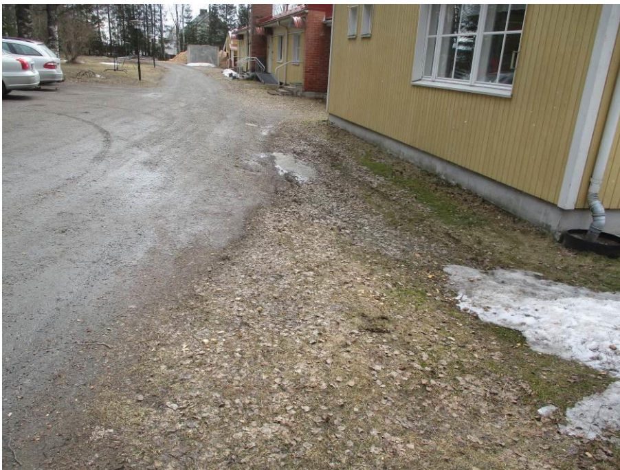
Kuva 5. Maanpinnan kaadot rakennukseen päin.
