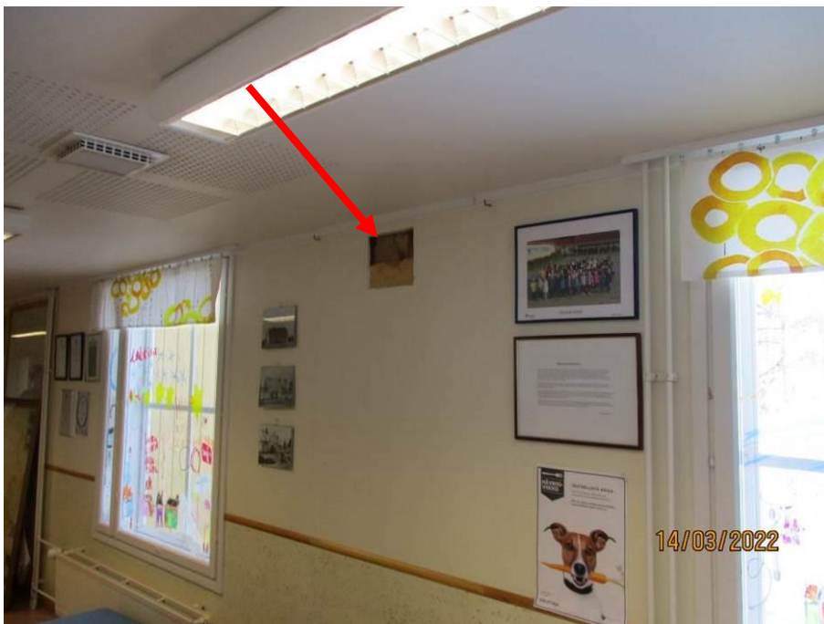
Kuva 55. Käytävän ulkoseinän rakenneavaus.
