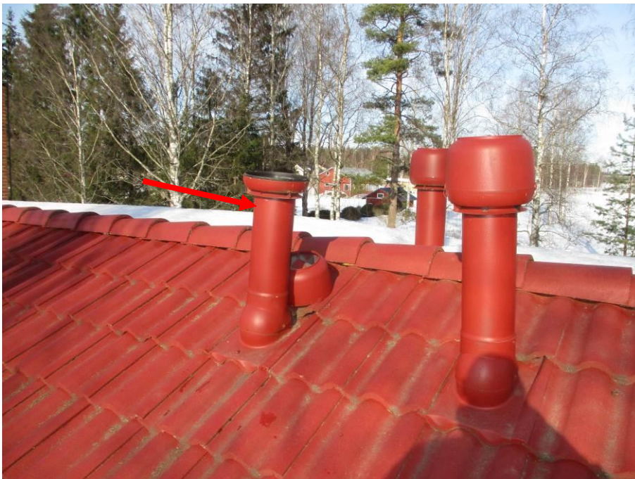
Kuva 71. Viemärin tuuletusputki.
