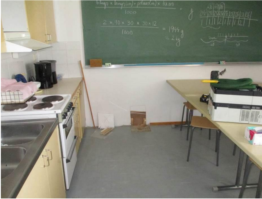
Kuva 46. Käsityökeskuksen ulkoseinän avaus.
