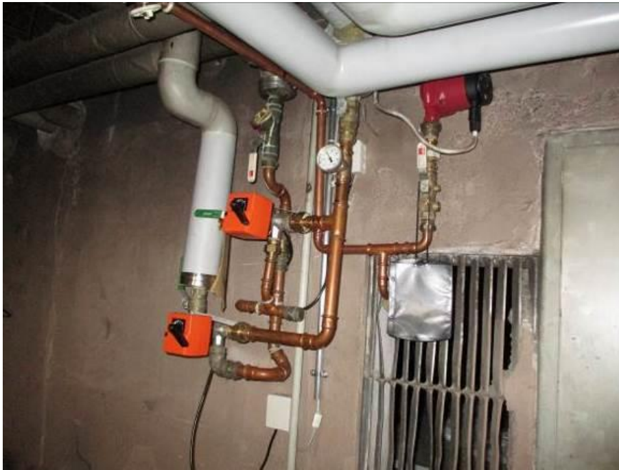
Kuva 143.säätömoottoreita
