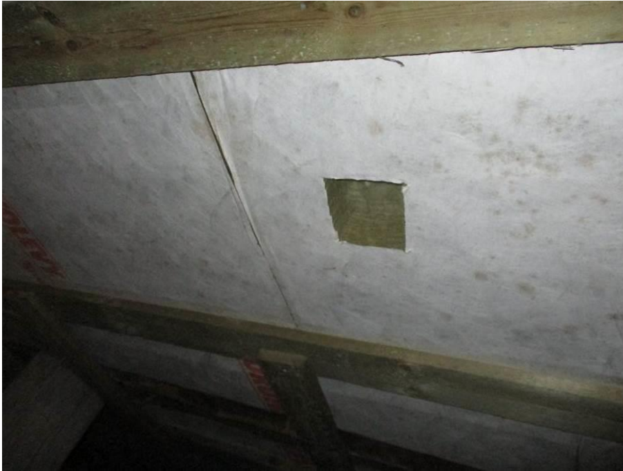
Kuva 29. Alapohjan tutkimusaukko.
