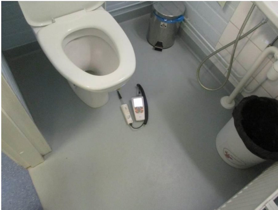
Kuva 30. Viiltomittaus, VM1 pukuhuonetilojen wc-tila
