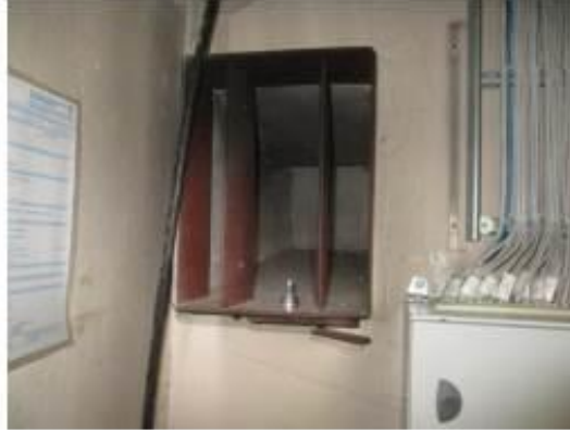
Kuva 2. Kantikas asbestisementtikanava.
