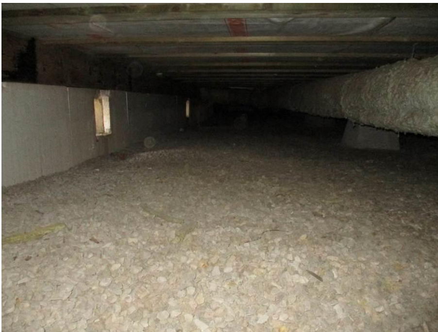
Kuva 22. Yleiskuva tuulettuvasta alapohjasta.
