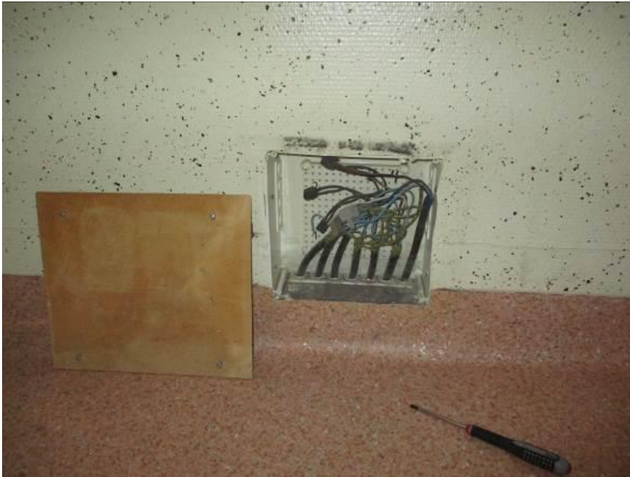
Kuva 183. Sähkörasian kansi vanerinen
