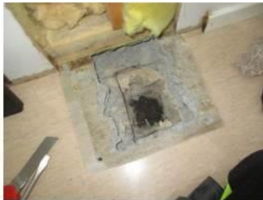
Kuva 10. PAH-yhdisteitä sisältävä tervapaperi ja pikisively.
