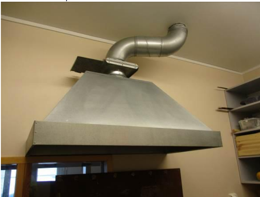
Kuva 172. kuumakäsittelyhuoneen huuva
