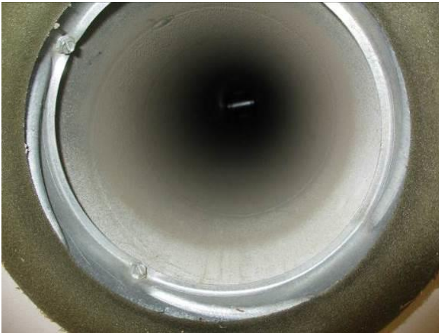
Kuva 173. Poistoilmakanavassa likaa
