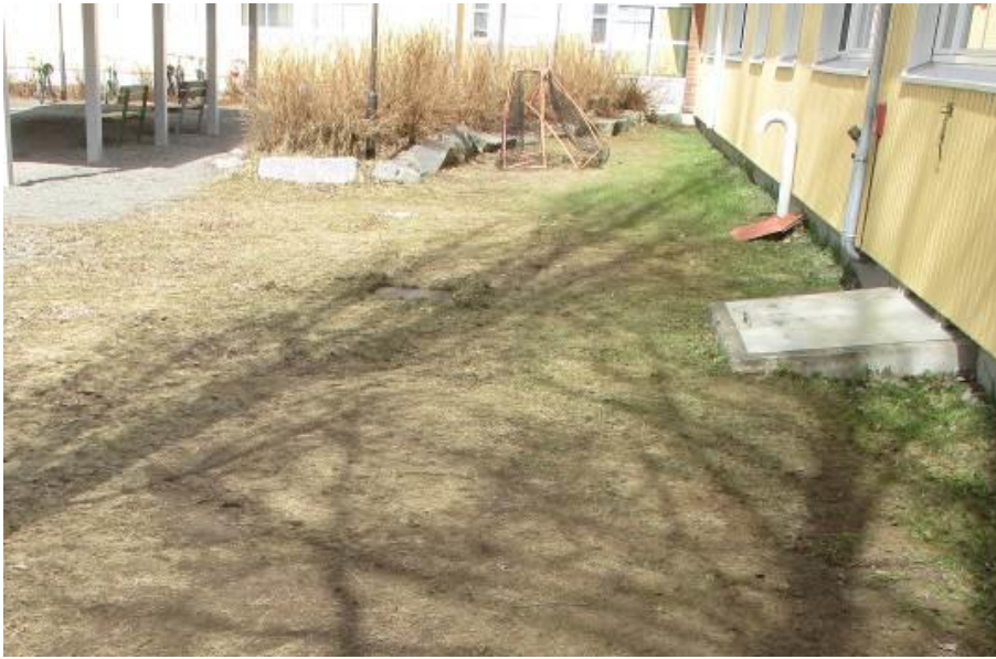
Kuva 2. Istutukset estävä pintaveden poistumista.
