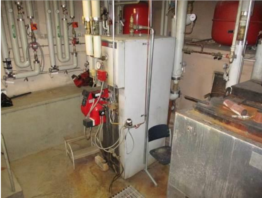
Kuva 139. Öljylämmityskattila
