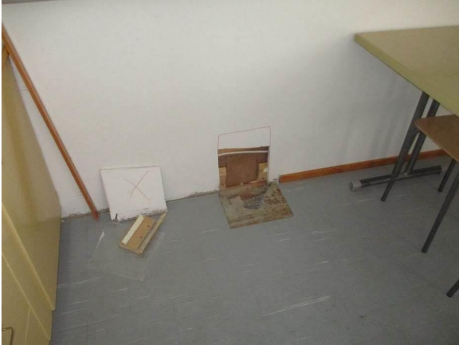
Kuva 32. Välipohjan rakenneavaus.
