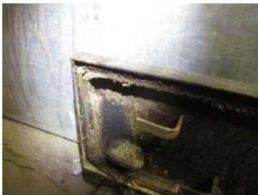
Kuva 5. Asbestipitoinen tiivistenauha.
