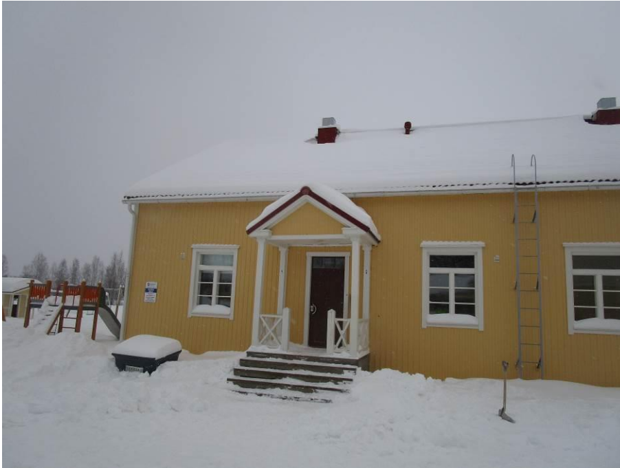
Kuva 6. Vanhan osan sisäänkäynnin katos.
