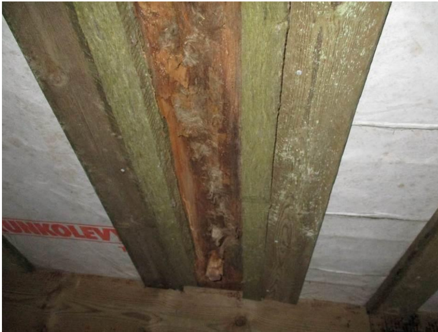
Kuva 27. Alkuperäisiä kantavia rakenteita.
