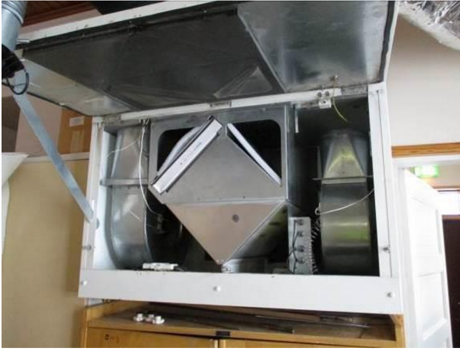
Kuva 169. Vanhan koulurakennuksen ilmanvaihtokone
