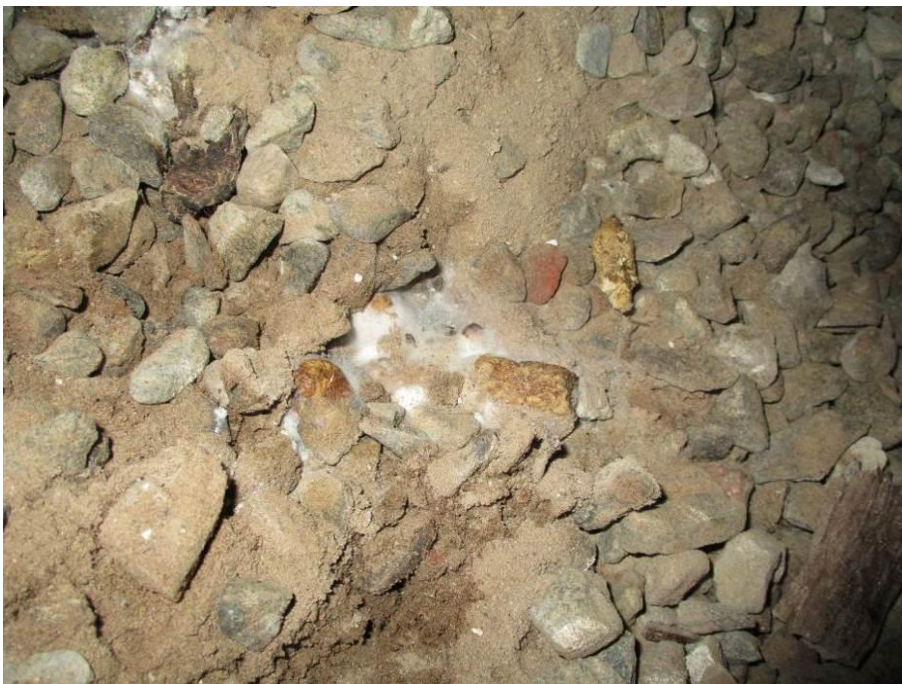
Kuva 24. Organiset materiaalit ovat vaurioituneet.
