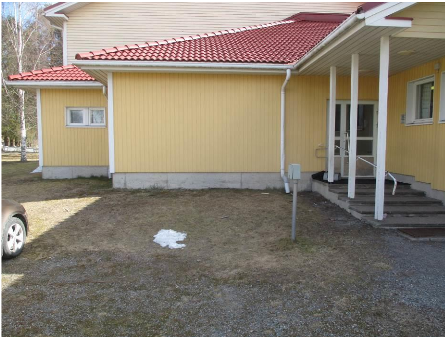
Kuva 17. Yleiskuva laajennuksen sokkelista.
