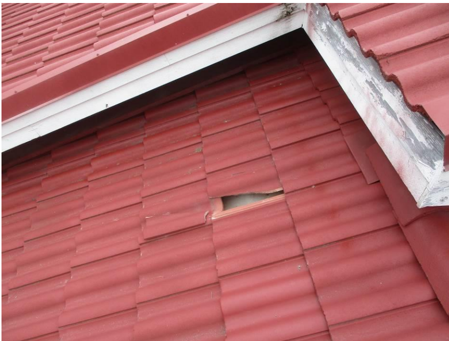
Kuva 75. Rikkinäisiä kattotiliä.
