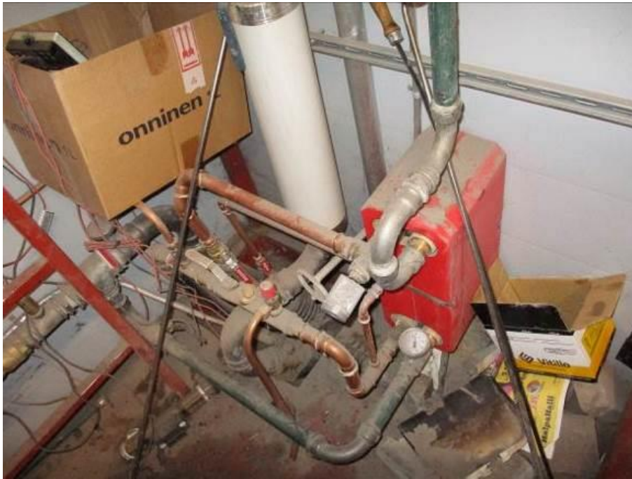
Kuva 135.Lämmönsiirrin
