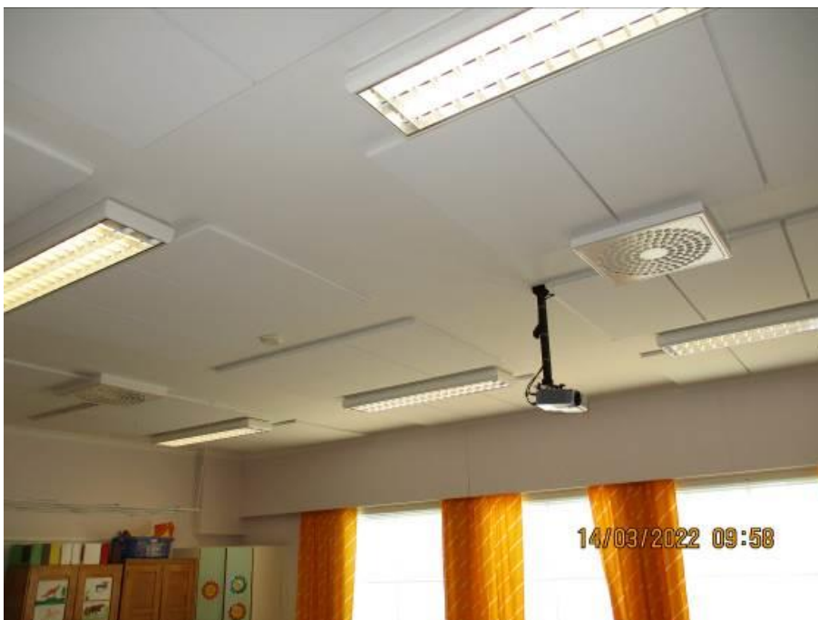
Kuva 177. Colibri tuloilmapäätelaite katossa.
