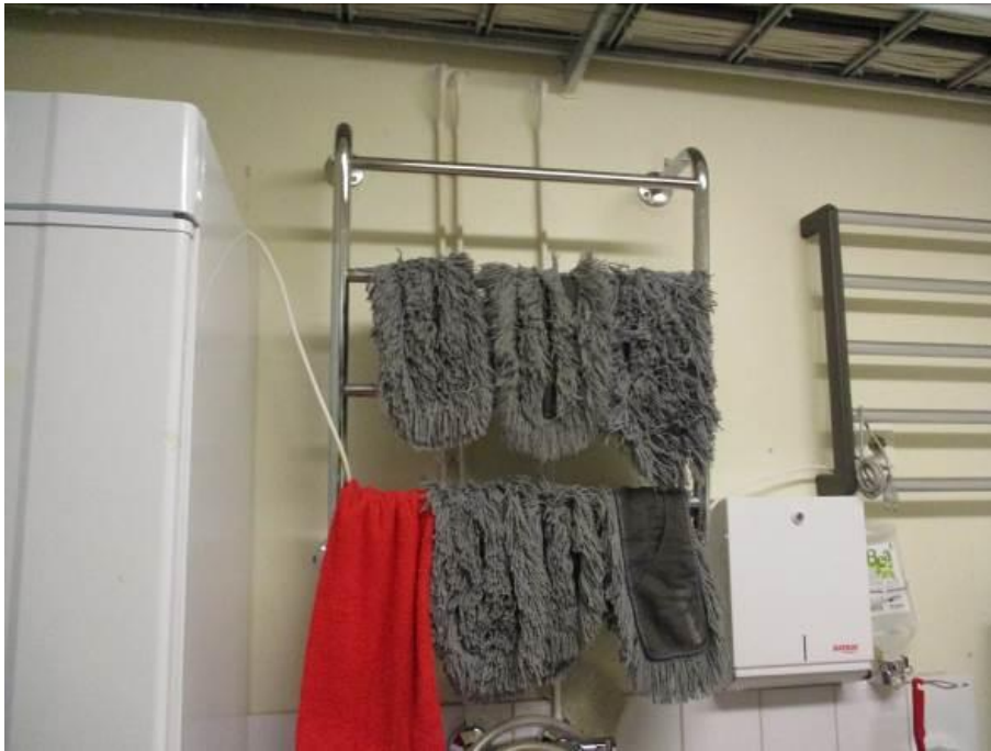
Kuva 158. Käyttövesipatteri
