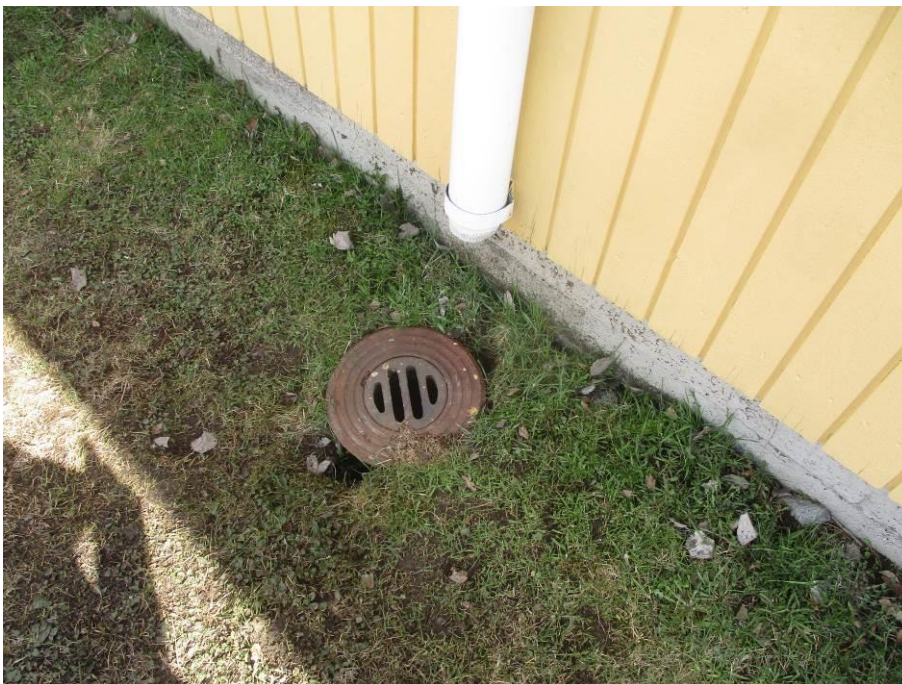
Kuva 14. Puutteellinen syöksytorvi.
