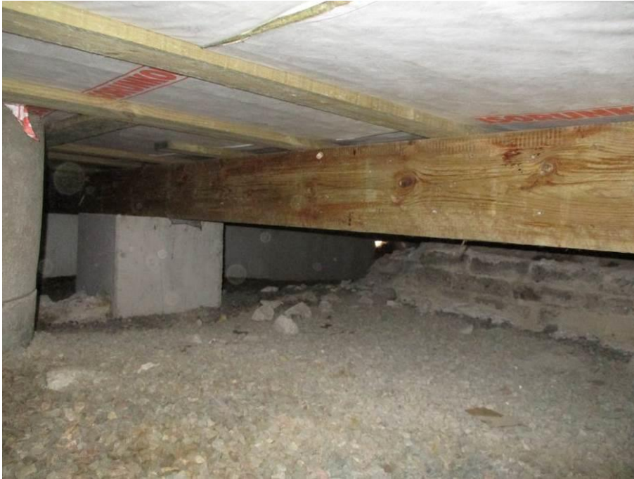
Kuva 21. Yleiskuva tuulettuvasta alapohjasta.
