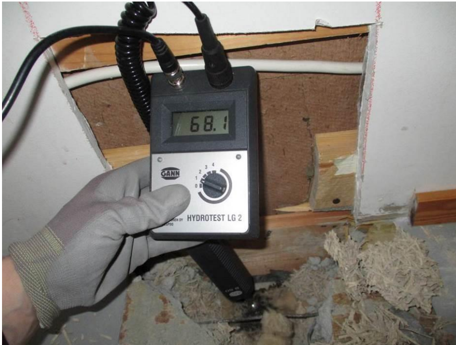
Kuva 34. Betonirakenteessa ei havaittu kohonneita kosteusarvoja.
