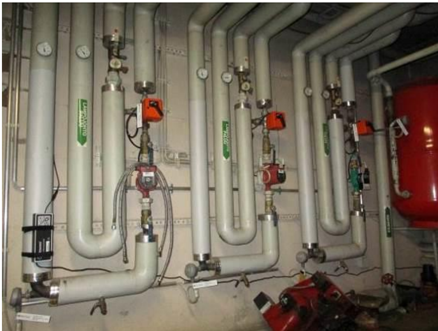
Kuva 142.Kiertovesipumppuja
