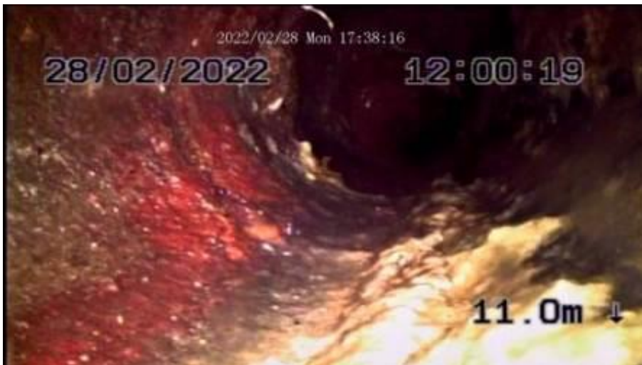
Kuva 155. Kuvaus 1: Valurautainen pohjaviemäri
