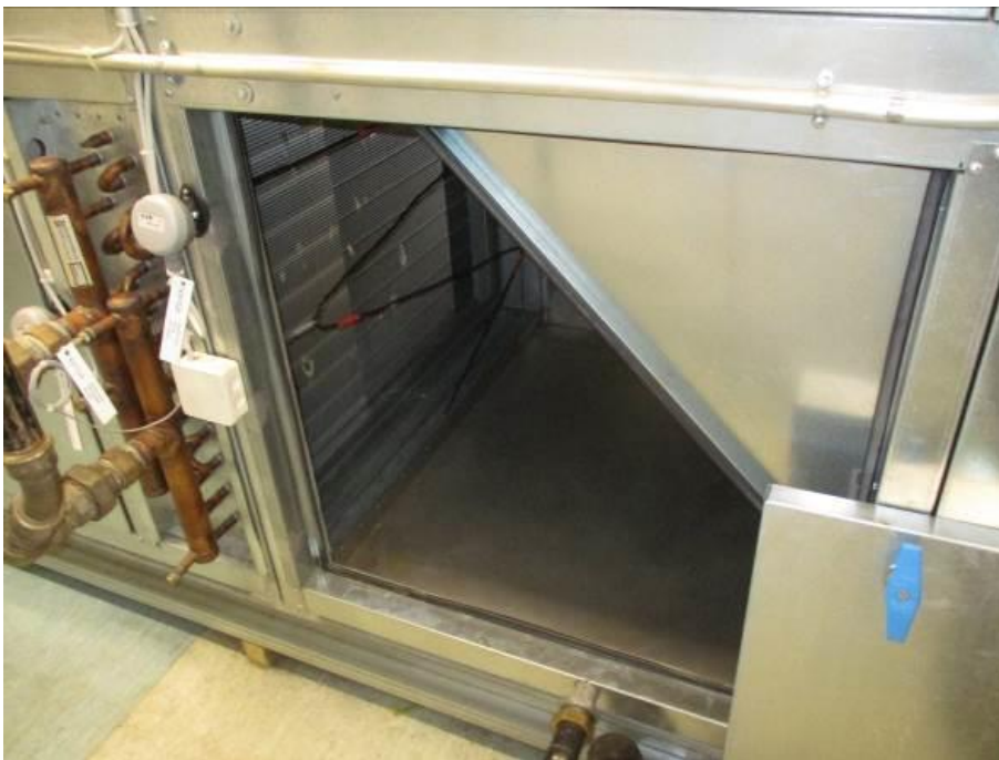
Kuva 164. Lämmöntalteenottokeino
