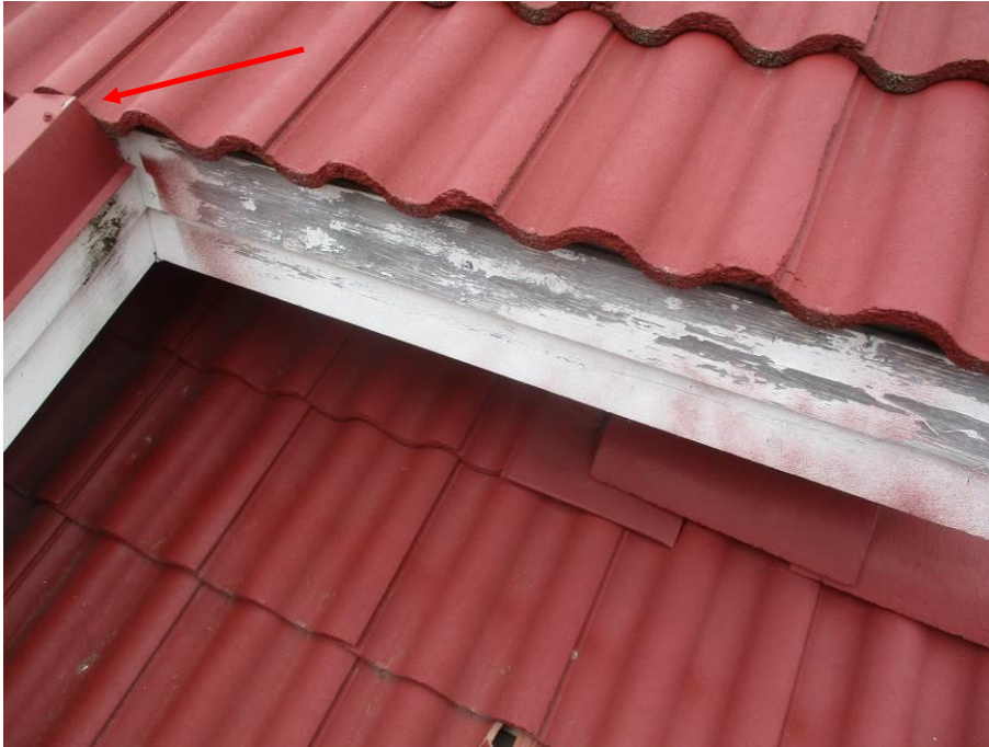
Kuva 78. Epätiivis liittyminen.
