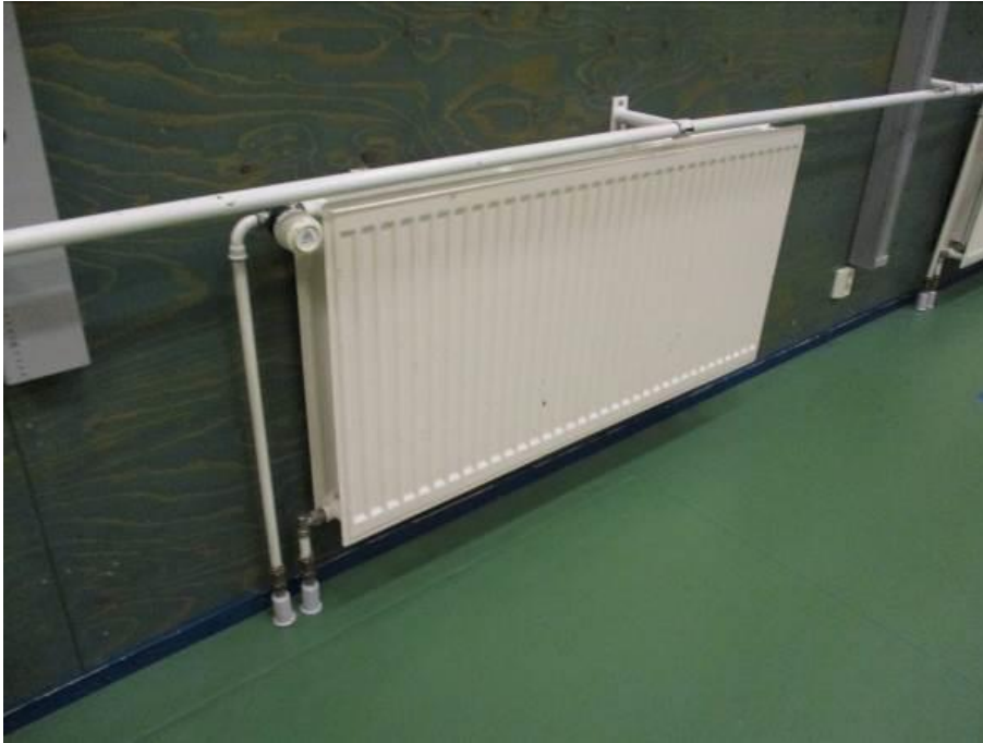
Kuva 145. Liikuntasalissa putket lattiarakenteessa muovia suojaputkessa
