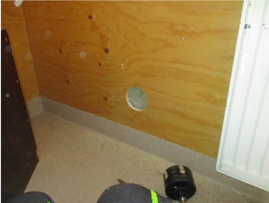
Kuva 58. Vanhan koulun ulkoseinän rakenneavaus.
