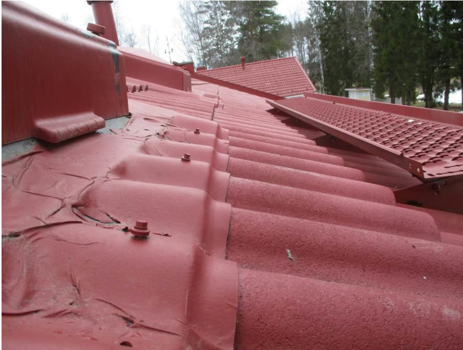
Kuva 76. Nousseet kiinnitysruuvit.
