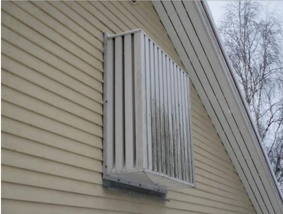
Kuva 161.raitisilmasäleikkö
