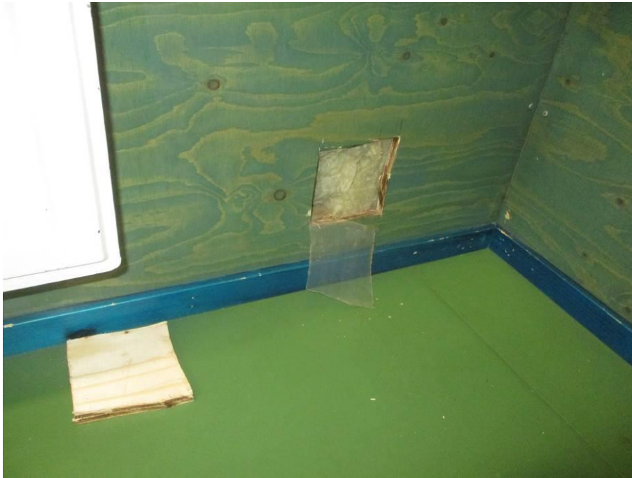
Kuva 60. Liikuntasalin ulkoseinän rakenneavaus.
