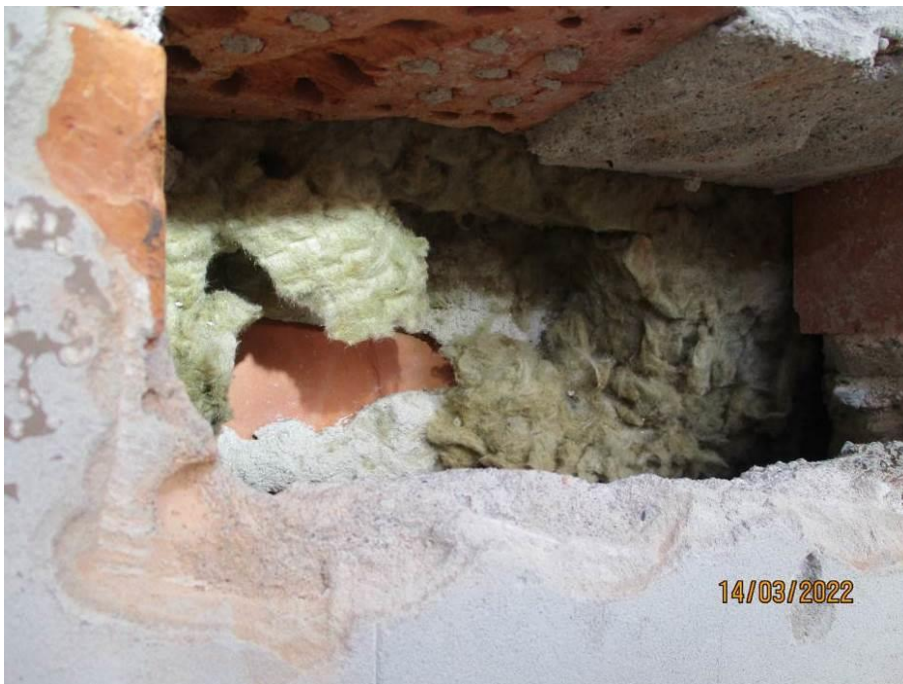
Kuva 38. Yleiskuva seinästä, kuoren välissä mineraalivilla.
