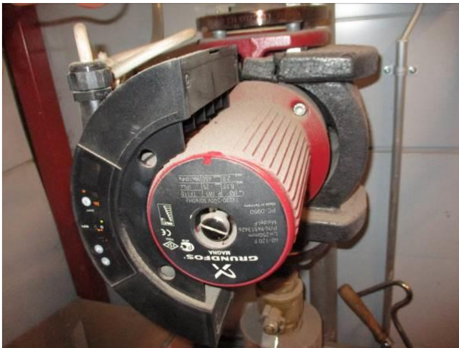
Kuva 136.Kiertovesipumppu
