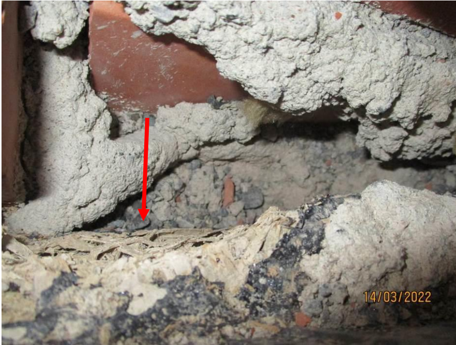
Kuva 39. Rakenteessa on Toja-eristys sokkelihalkaisuna.
