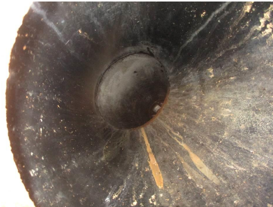
Kuva 15. Vääntynyt tarkistuskaivon säätöputki.
