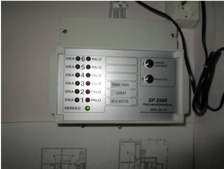
Kuva 186. Paloilmoitinjärjestelmä
