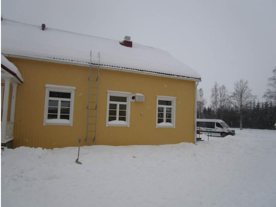
Kuva 64. Vanhan osan julkisivu.
