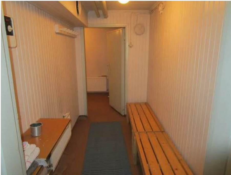
Kuva 91. Pukuhuonetila ja pesuhuone
