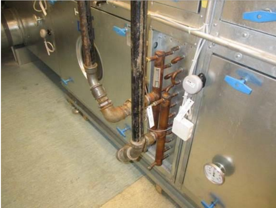
Kuva 165. Lämmityspatteri
