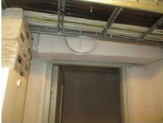
Kuva 1. Kantikas asbestisementtikanava.
