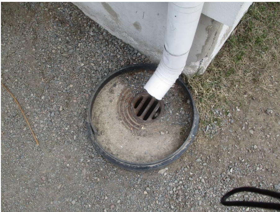
Kuva 12. Sadevesikaivolle tehty kaulus.
