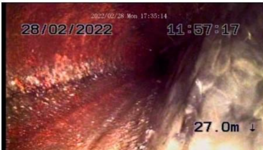
Kuva 153. Kuvaus 1: Valurautainen pohjaviemäri
