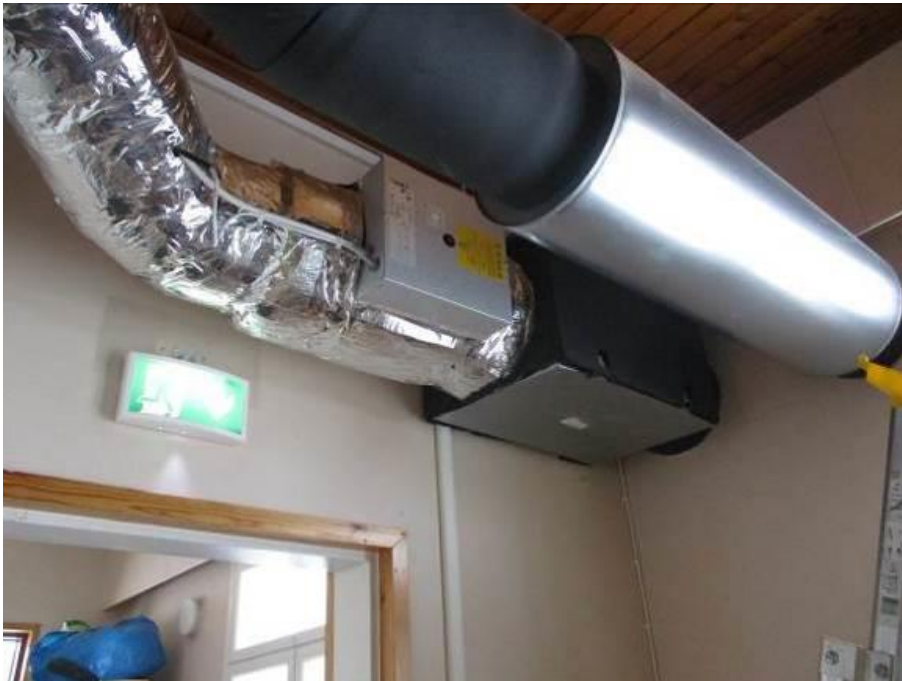
Kuva 170. esilämmityspatteri
