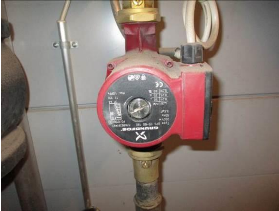
Kuva 137. Kiertovesipumppu
