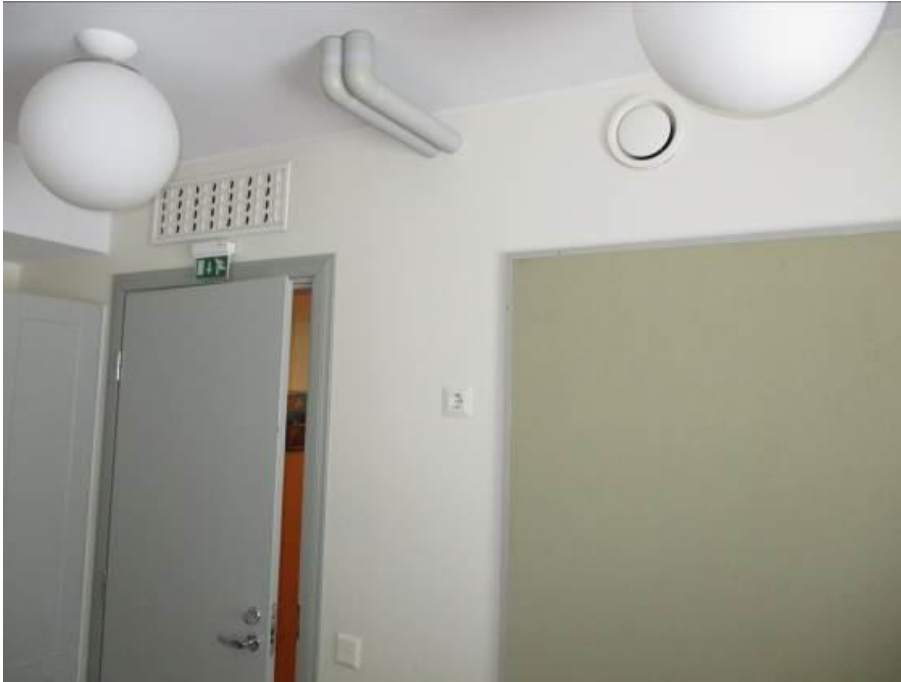
Kuva 198. Poistoilmapäätelaitteita
