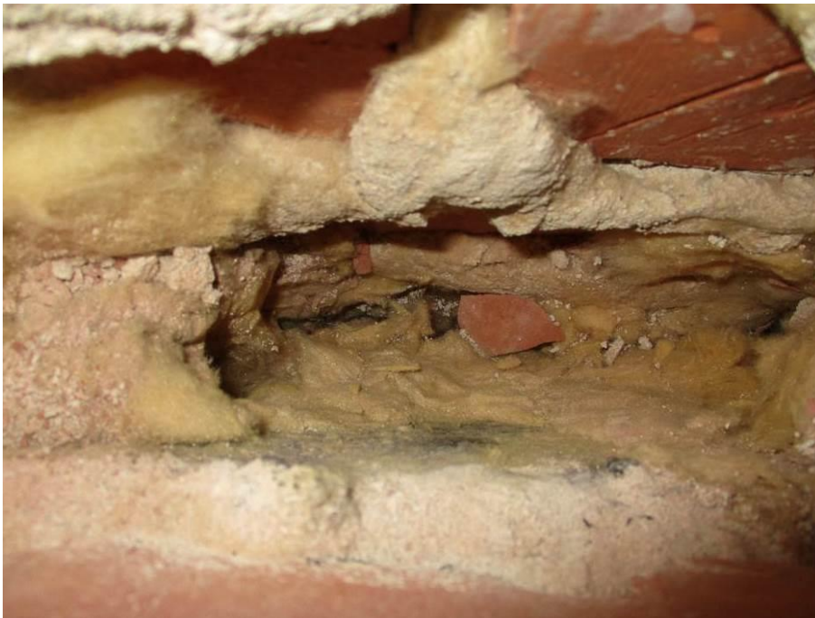
Kuva 54. Väliseinässä on mineraalivillaeristys.
