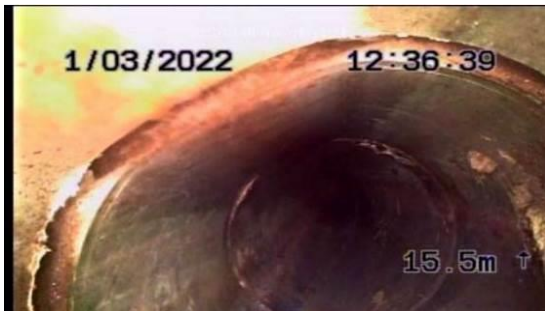
Kuva 154. Kuvaus 4: Mahdollisesti epätiivis puhdistusluukun liitos
