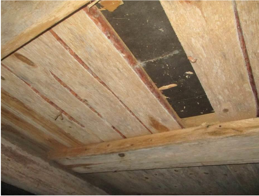
Kuva 27. Täytepohjan aluslautojen päällä on tervapaperi.
