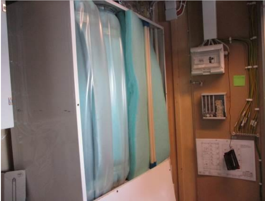
Kuva 196. Koneen yläpuolella oleva tehdastekoinen äänenvaimenninyksikkö.
