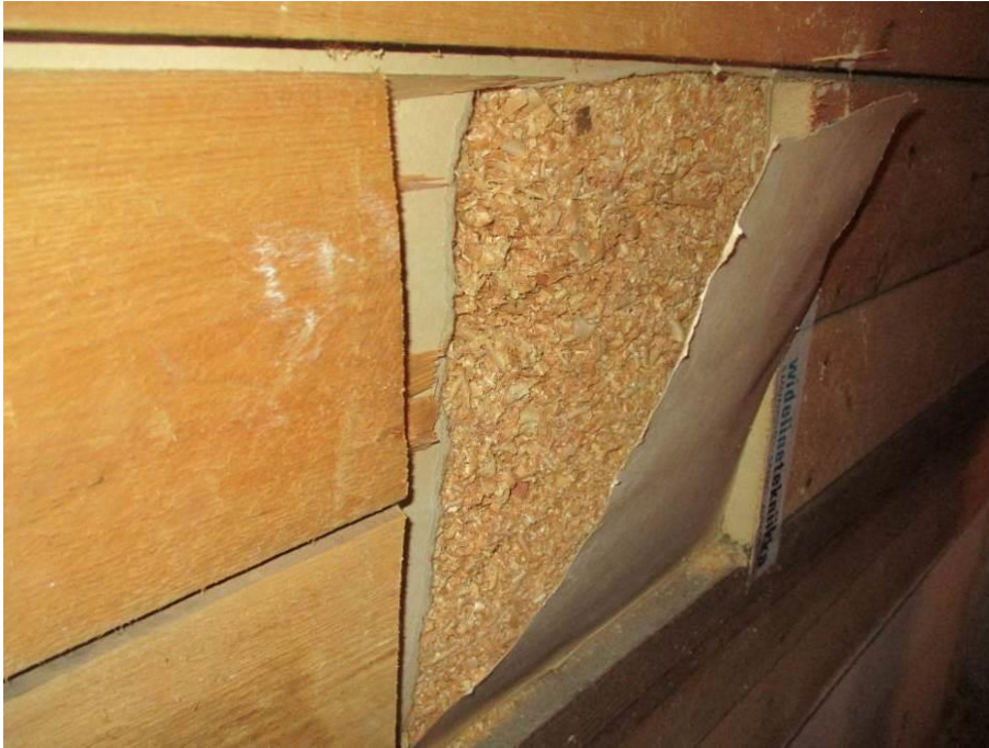
Kuva 51. Kellarin väliseinässä on purueristys.
