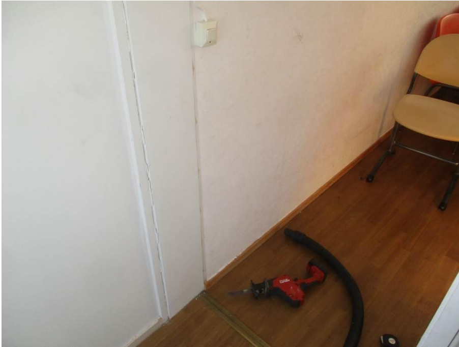
Kuva 62. 2. kerroksen asunnon ulkoseinä.
