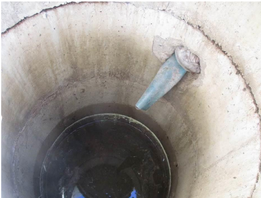
Kuva 16. Kaivoon johdettu muoviputki.
