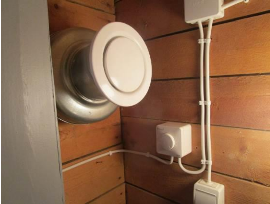
Kuva 201. Kellarin kanavapuhallin
