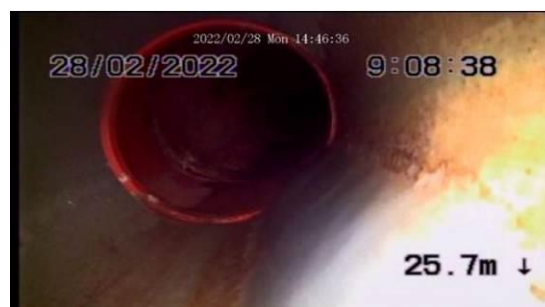
Kuva 151. Kuvaus 1: Valurautaisen viemärin kulmaosa: Valurautaisen ja muovisen viemärin liitos
