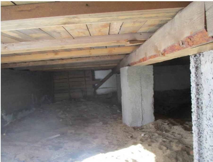
Kuva 30. Yleiskuva esikoulun alapohjasta.
