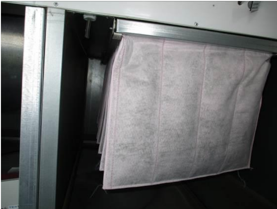
Kuva 176. TK03 tuloilmasuodatin
