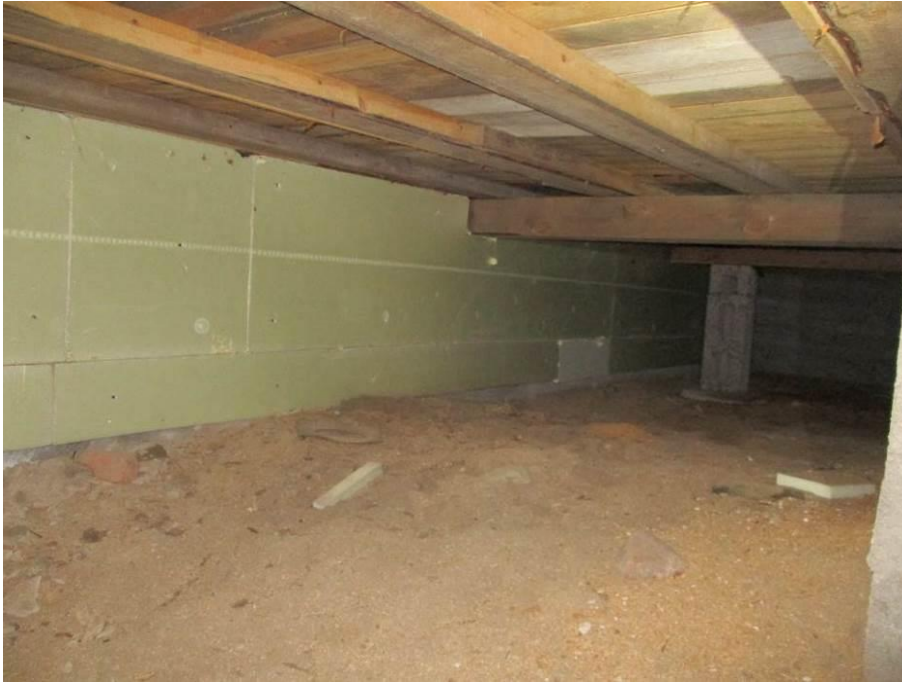
Kuva 31. Yleiskuva alapohjan tuuletustilasta.
