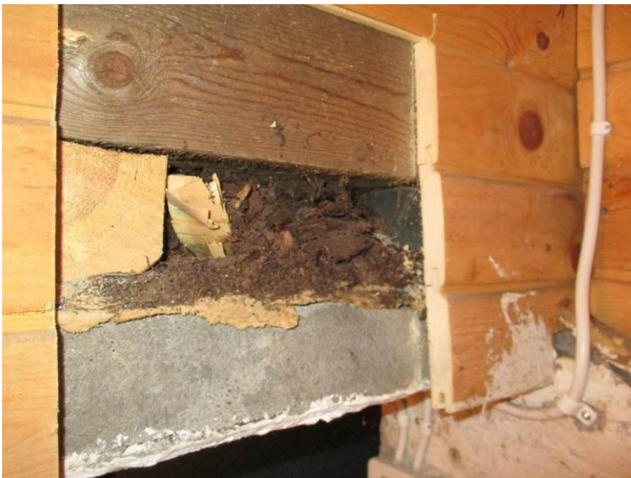
Kuva 47. Välipohjassa on turve-eristys.
