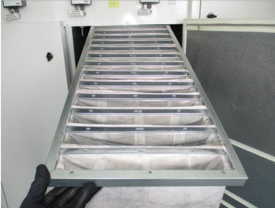
Kuva 169. Tuloilmasuodatin
