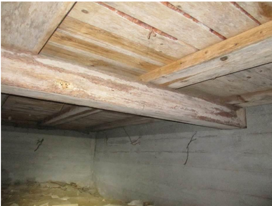
Kuva 24. Kantavien rakenteiden tuenta sokkelista.
