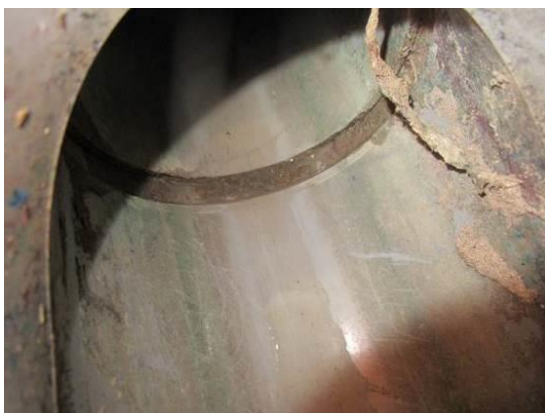
Kuva 155. Puhdistushaaraosassa viemäriputkea ei ole asennettu liitoksen perille asti
