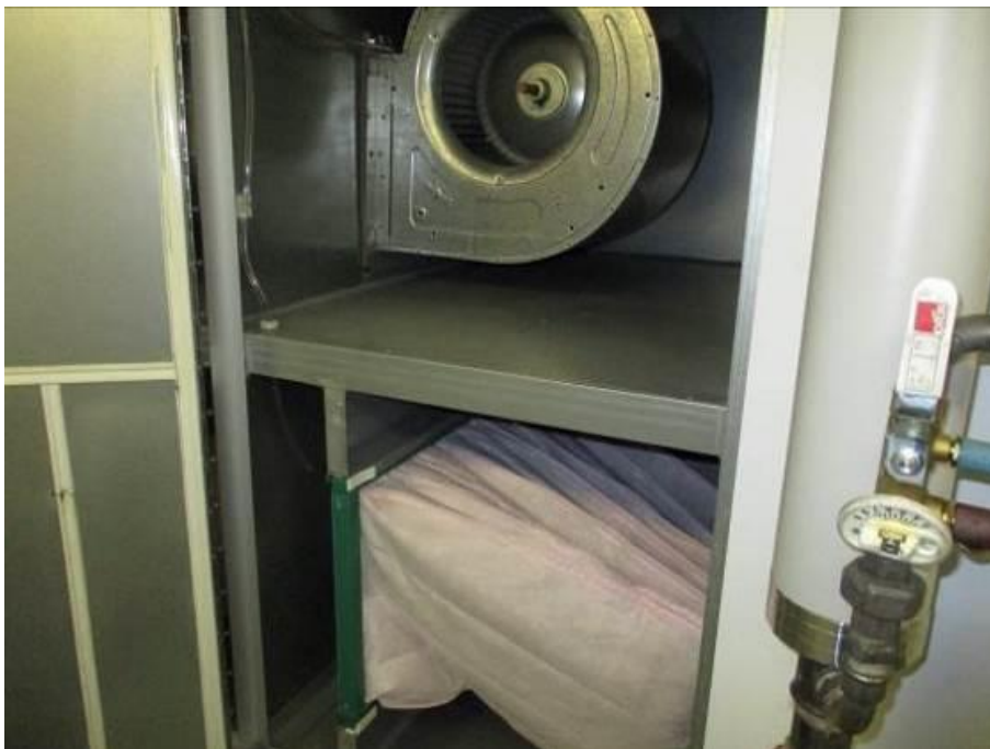
Kuva 163. Puhallin ja suodattimet
