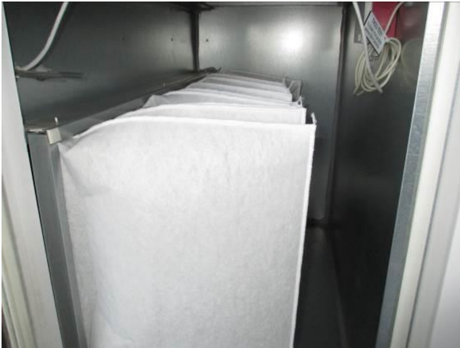
Kuva 177. Poistoilmasuodatin
