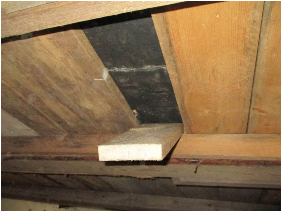
Kuva 32. Tervapaperi täytepohjan aluslautojen päällä.
