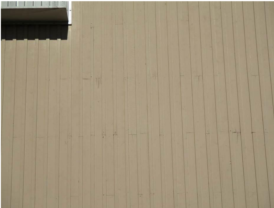
Kuva 67. Lahovaurioituneita lautoja.
