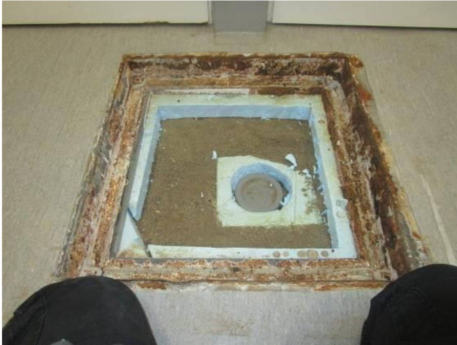
Kuva 149. Laajennusosan käytävällä oleva viemärin tarkastuskaivo
