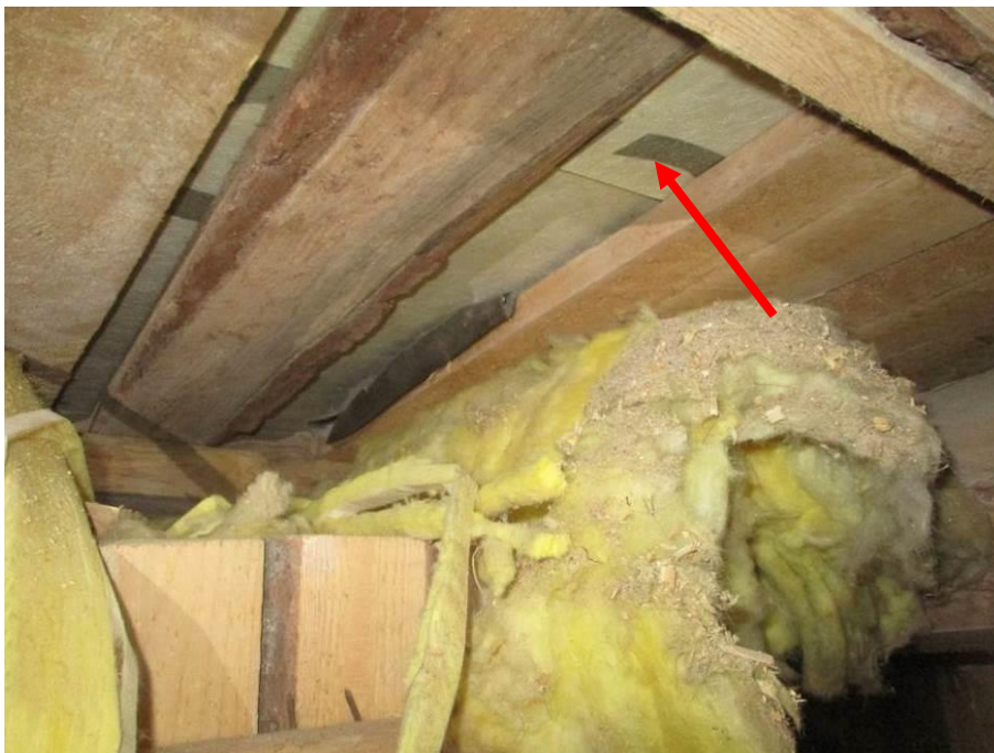
Kuva 26. Mineraalivillaa alapohjarakenteessa.
