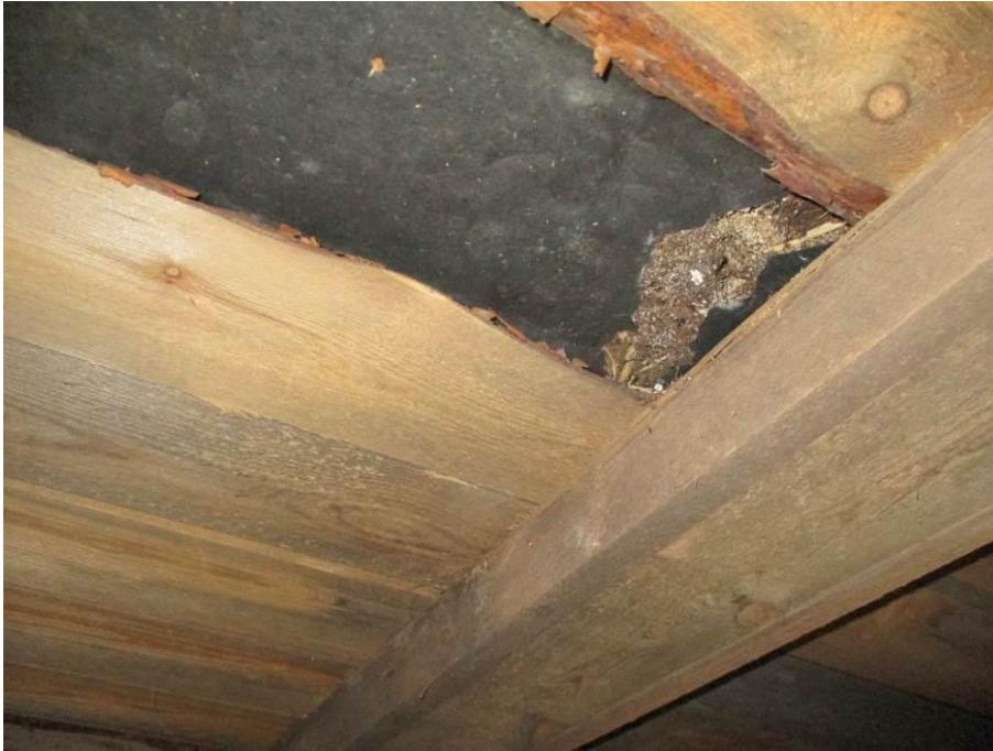
Kuva 33. Turvetta alapohjan eristeenä.
