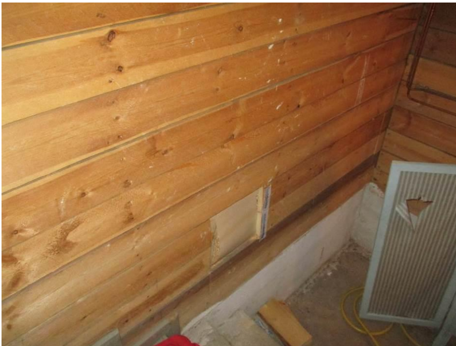
Kuva 50. Esikoulun kellarin väliseinän avaus.
