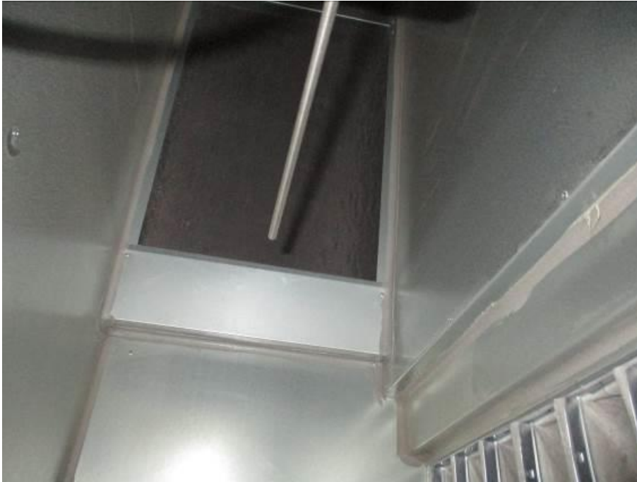
Kuva 175. Poistoilmakammio
