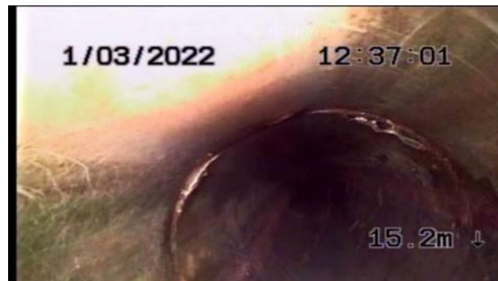
Kuva 154. Kuvaus 4: Mahdollisesti epätiivis puhdistusluukun liitos
