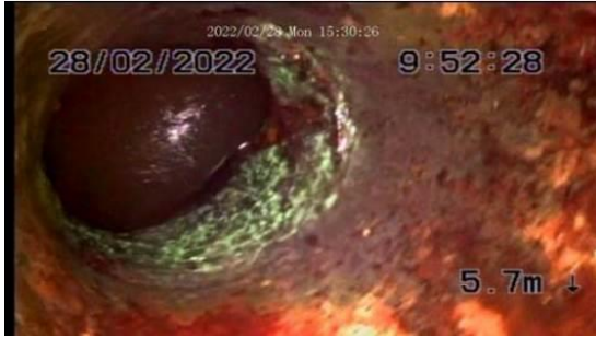
Kuva 153. Kuvaus 3: Tukossa oleva pohjaviemäri. Muovisen ja valurautaisen viemärin liitos
