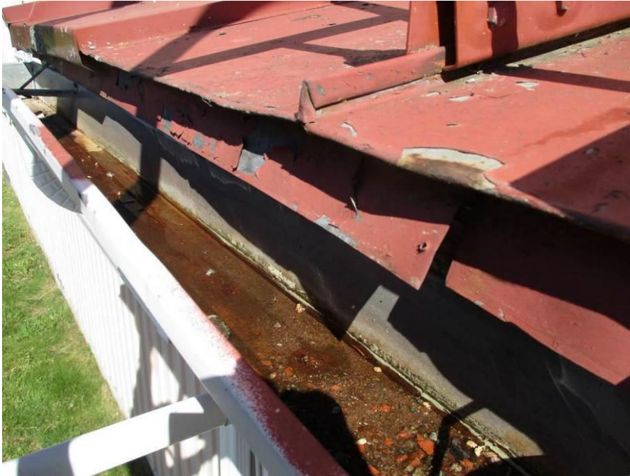
Kuva 78. Alaräystäällä ruostetta.
