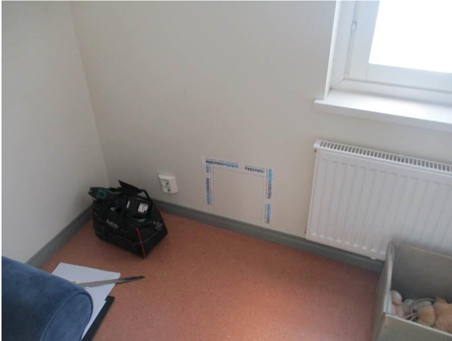
Kuva 60. Esikoulun ulkoseinän rakenneavaus.
