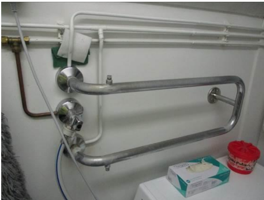
Kuva 158. Siivouskomerossa oleva rätipatteri
