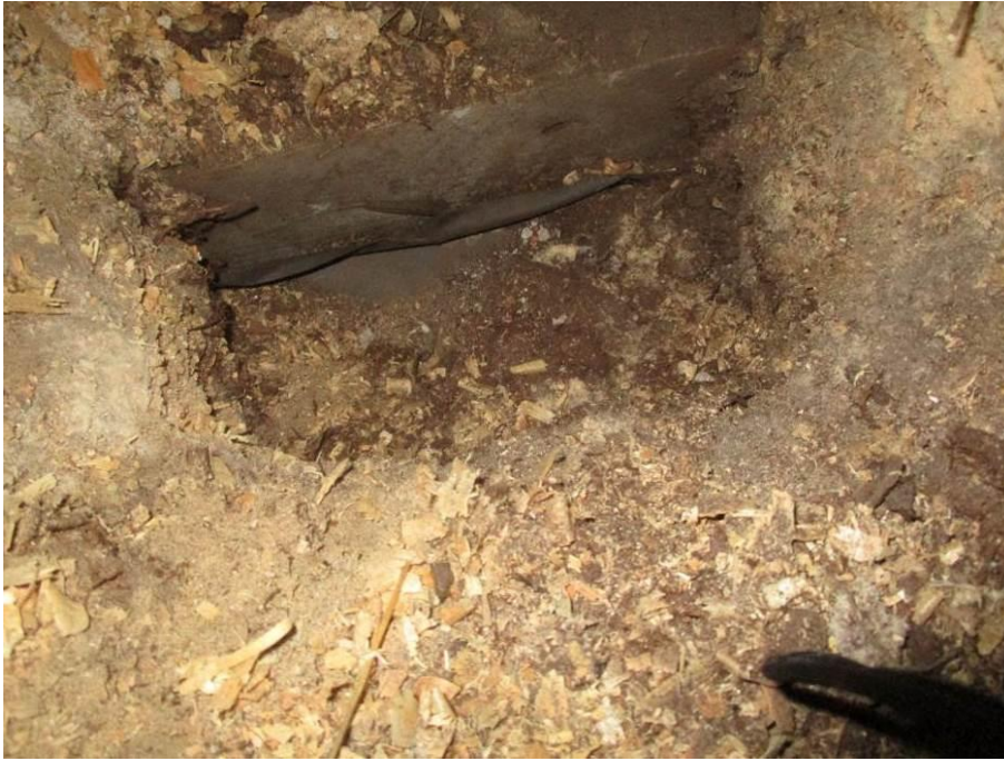
Kuva 86. Yleiskuva asunnon osan yläpohjasta.
