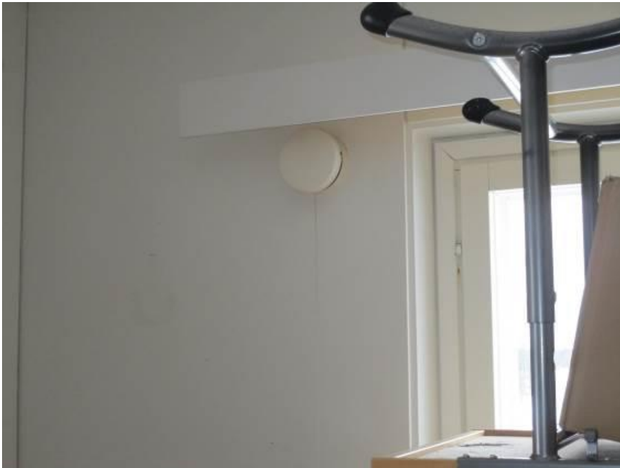
Kuva 200. Korvausilmaventtiili
