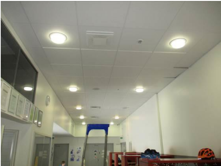
Kuva 190. Kattomallin tuloilmasäleikkö
