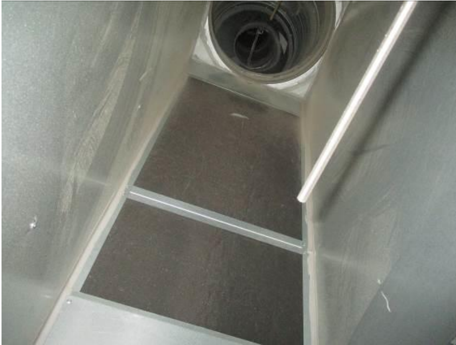
Kuva 187. Koneen poistoilmakammio
