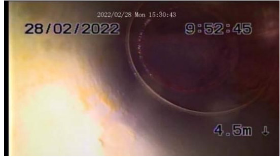
Kuva 153. Kuvaus 3: Tukossa oleva pohjaviemäri. Muovisen ja valurautaisen viemärin liitos
