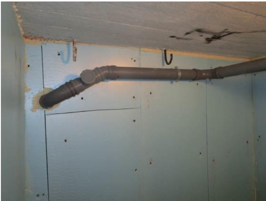
Kuva 148. Opettajanhuoneen kellarissa oleva viemäriputki ja tarkastusluukku (kuvaus 4.).
