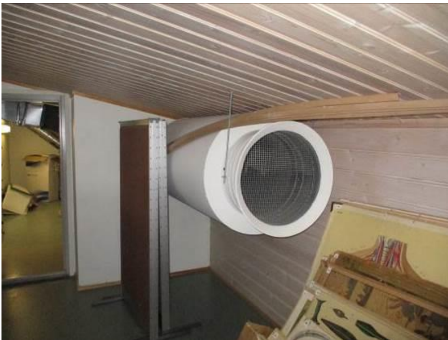
Kuva 167. Parvella oleva poistoimukartio
