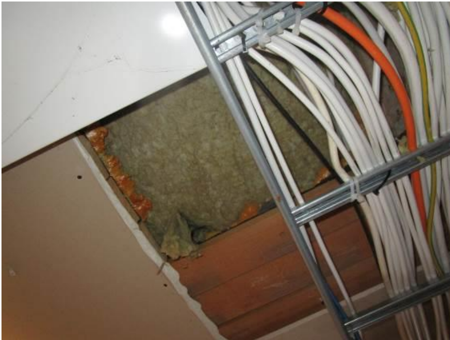
Kuva 120. Katto osittain levytetty
