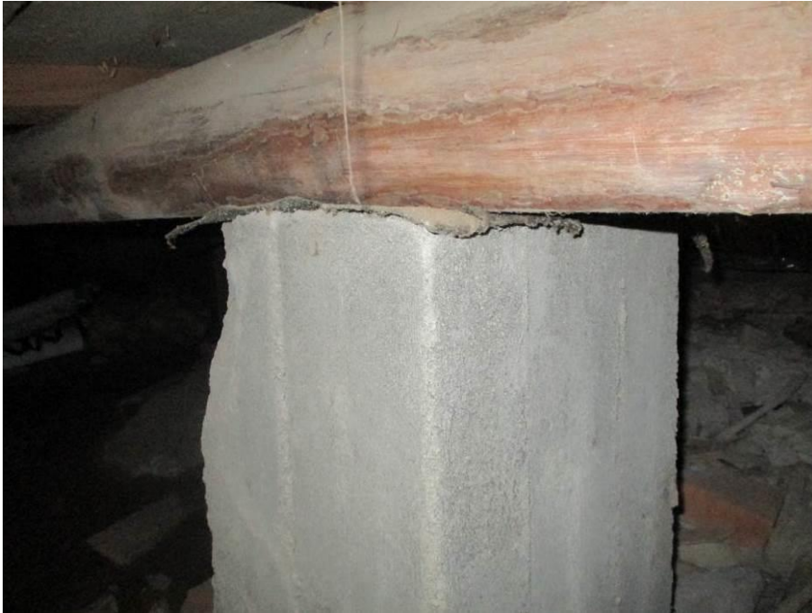
Kuva 23. Kantavat rakenteet asennettu betonianturan varaan.
