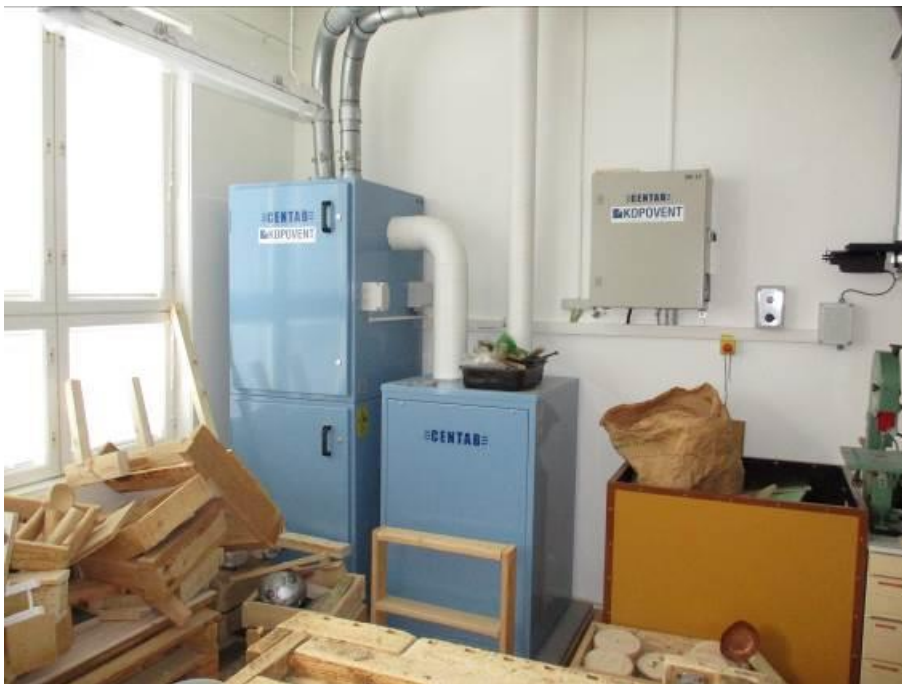
Kuva 181. Purunpoistojärjestelmä
