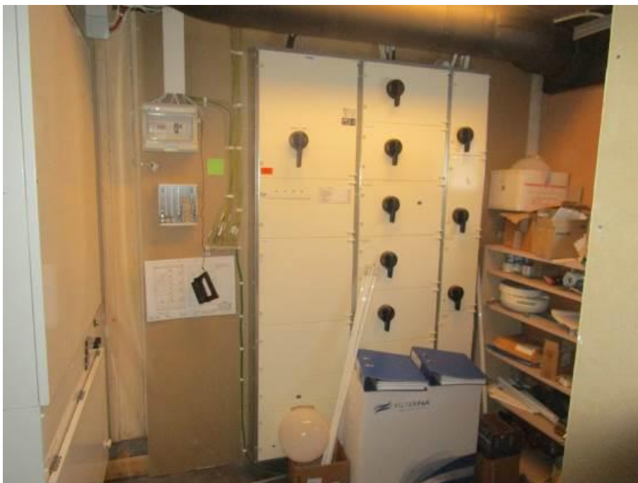
Kuva 202. Sähköpääkeskus
