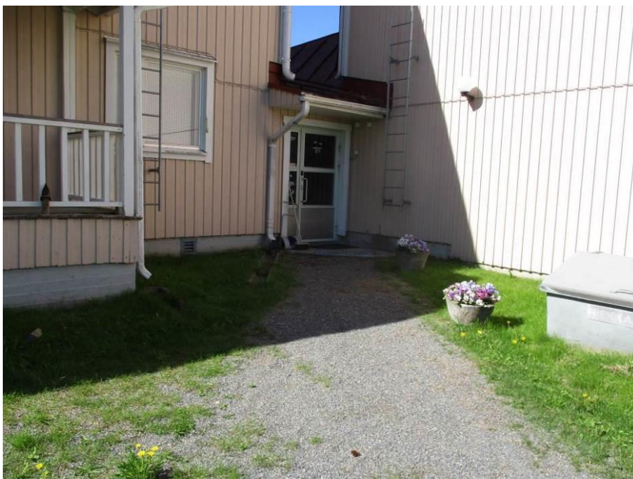
Kuva 11. Kattovedet johdettu rakennuksen vierustalle.
