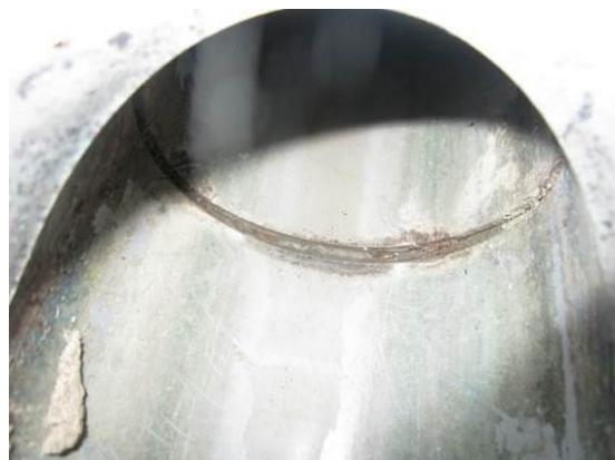
Kuva 155. Puhdistushaaraosassa viemäriputkea ei ole asennettu liitoksen perille asti
