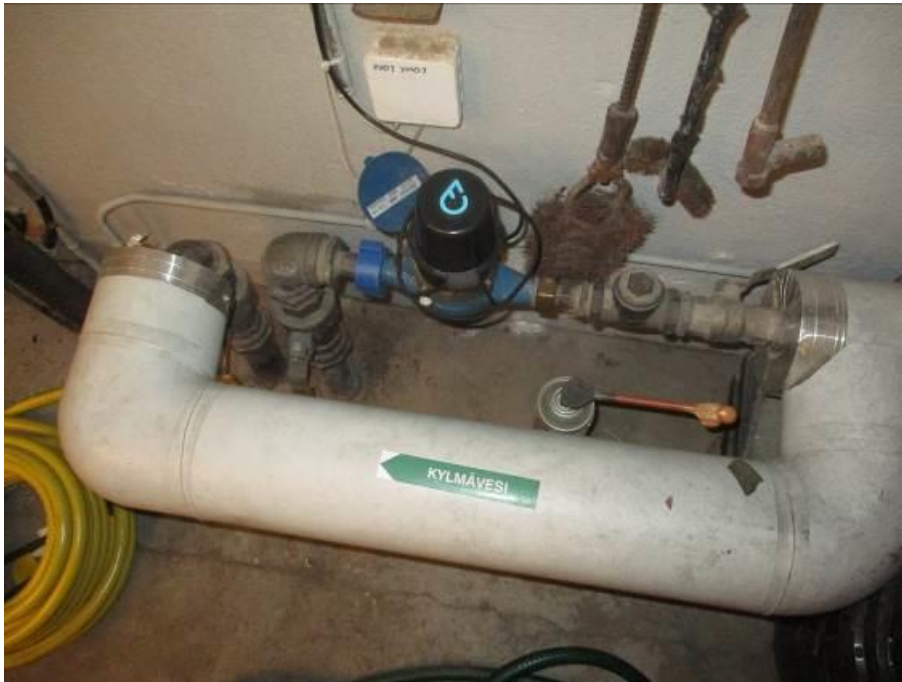
Kuva 143. Päävesimittari
