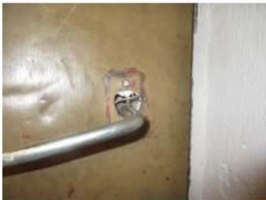
Kuva 5. LJH palo-ovet sisältävät asbestia.
