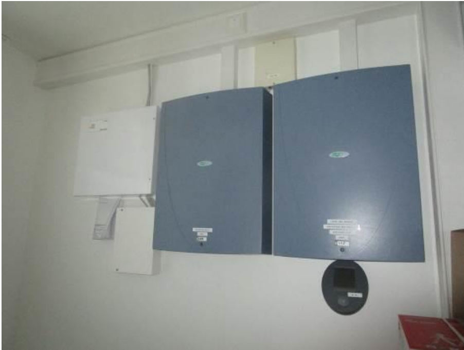
Kuva 216. Kulunvalvontajärjestelmä opettajanhuoneessa
