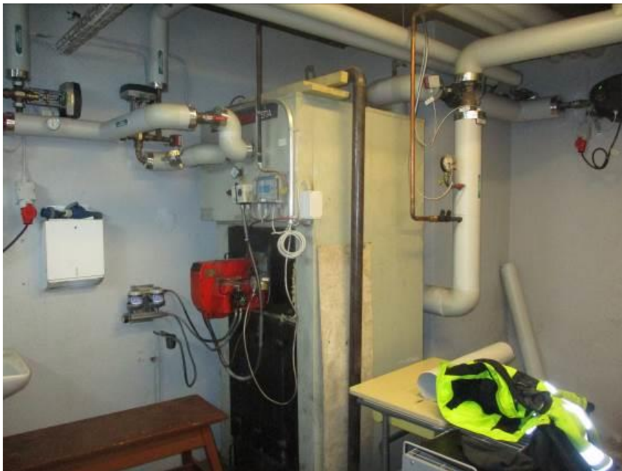
Kuva 135. Öljykattila ja -poltin
