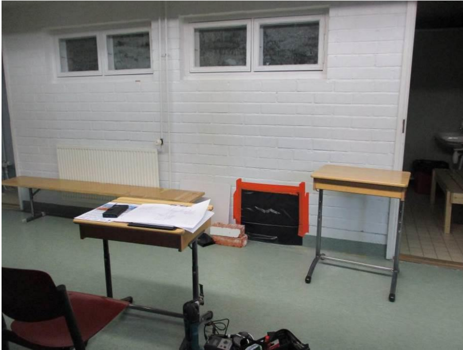
Kuva 53. Pukuhuoneen väliseinän rakenneavaus.
