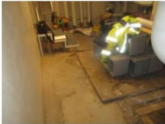
Kuva 7. Raskasmetalleja sisältävä lattiabetonimaali.
