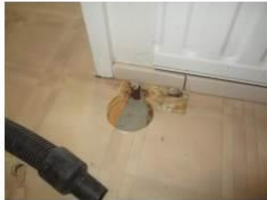
Kuva 8. Lyijyä sisältävä puulattiamaali.
