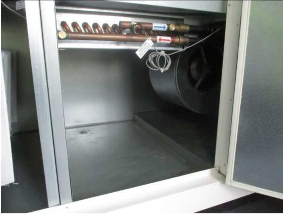
Kuva 173. Jälkilämmityspatteri
