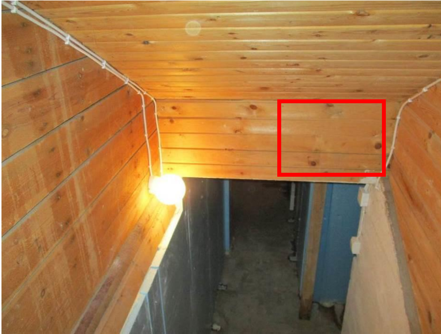
Kuva 46. Yleiskuva kellarista. Avaus tehtiin välipohjaan.
