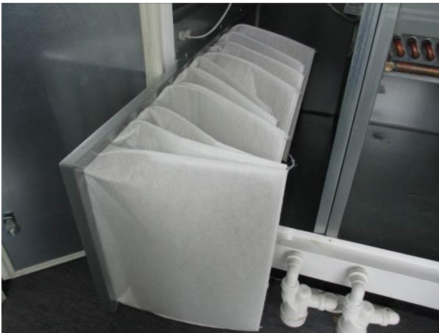
Kuva 170. TK02 poistoilmasuodatin
