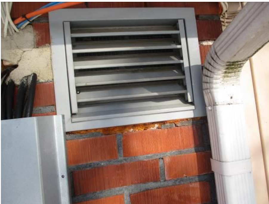
Kuva 195. Raitisilmasäleikkö
