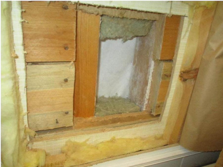
Kuva 55. Opettajien huoneen rakenneavaus.
