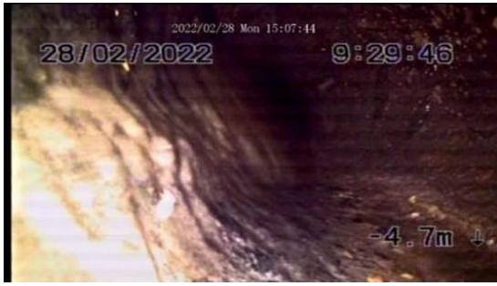
Kuva 152. Kuvaus 2: Tukossa oleva valurautainen pohjaviemäri. Muovinen viemäri.
