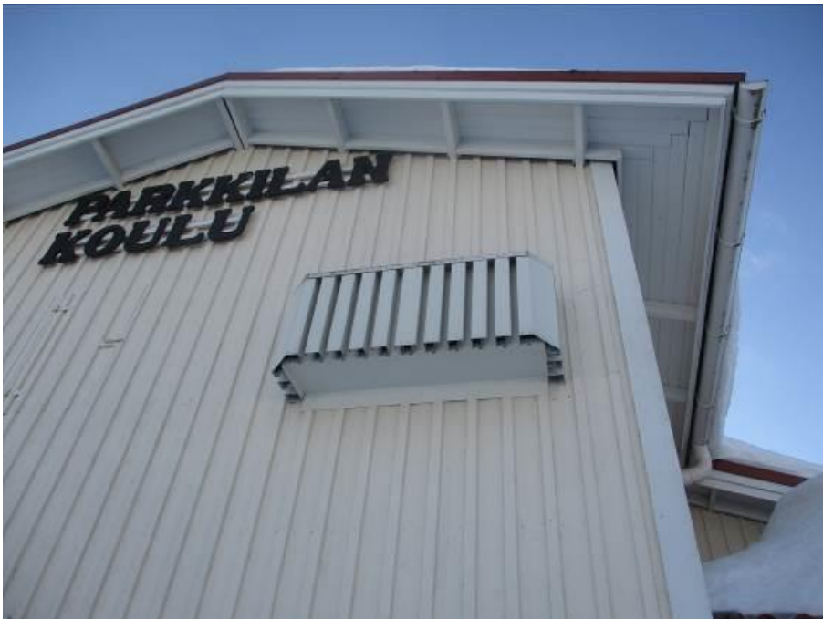
Kuva 188. Raitisilmasäleikkö
