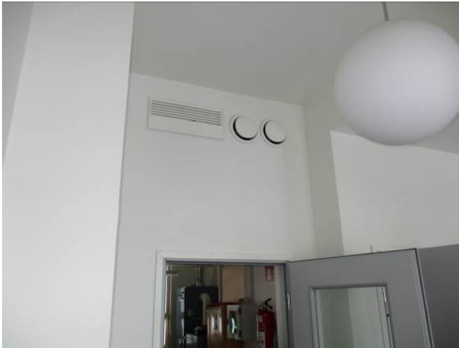
Kuva 182. Päätelaitteita käytävällä
