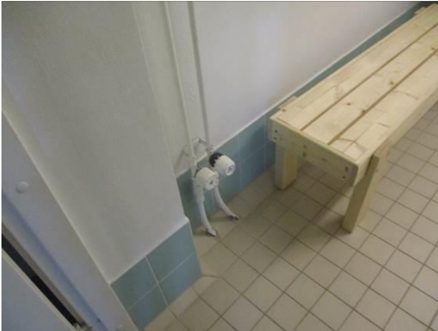
Kuva 141. Pukuhuoneiden lattialämmitysputkistoja.
