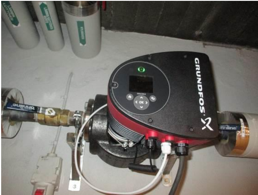
Kuva 136. Kiertovesipumppuja
