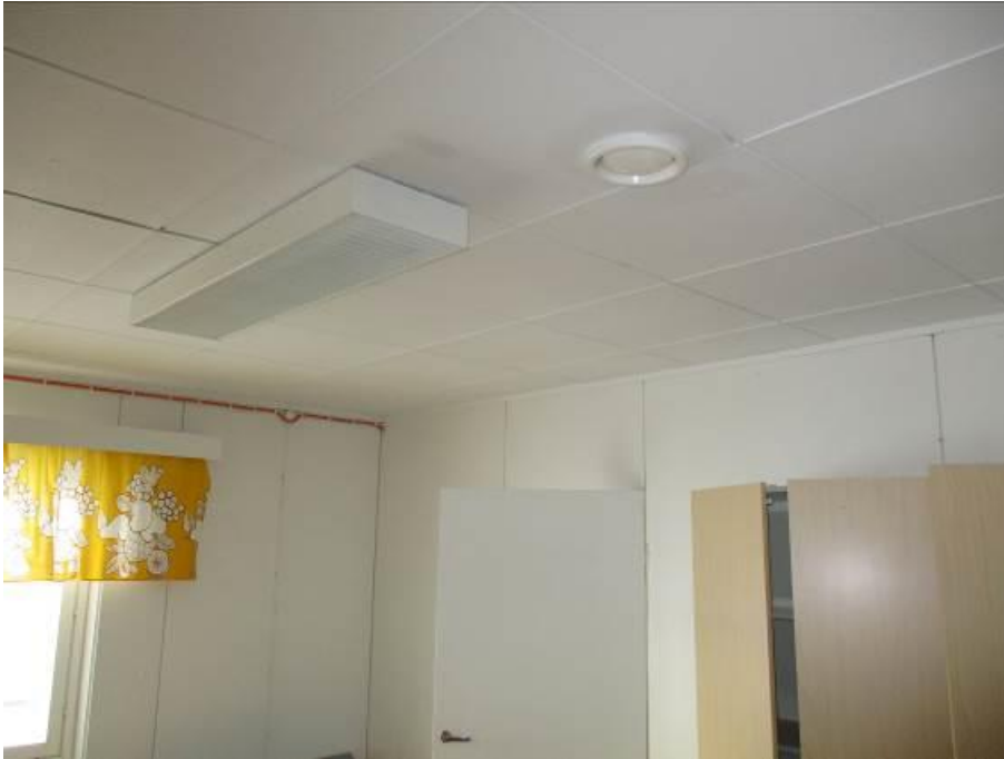
Kuva 199. Poistoilmanvaihtoventtiili
