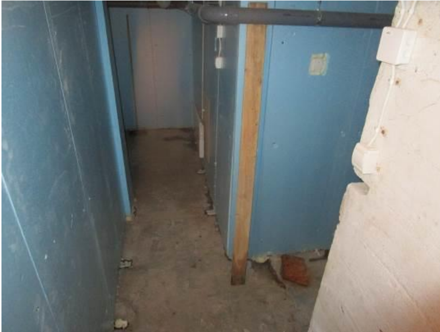
Kuva 106. Opettajien huoneen alapuolinen kellaritila
