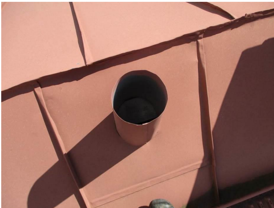
Kuva 71. Yläpohjan alipainetuuletin.
