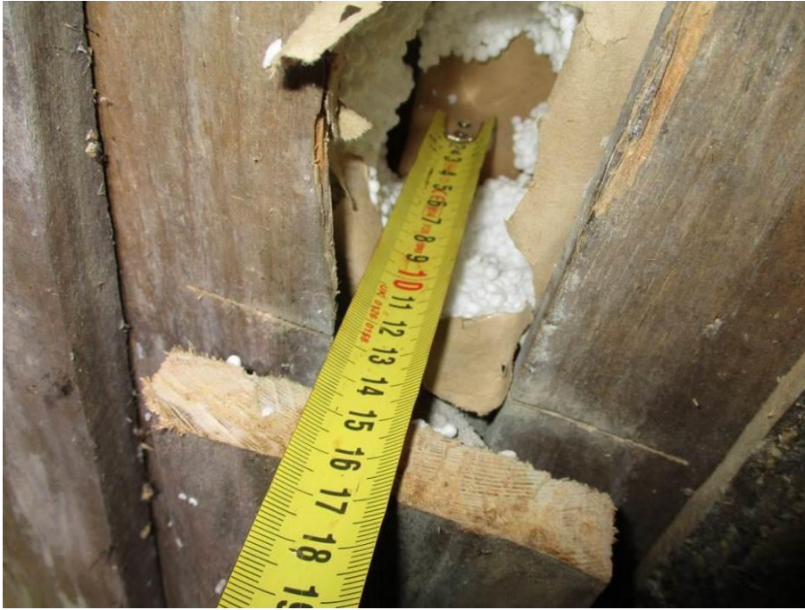
Kuva 32. Alapohjassa EPS-eristettä.
