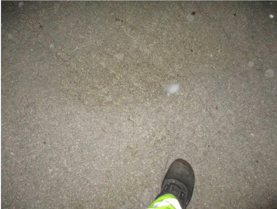
Kuva 81. Lunta on päässyt yläpohjaan.
