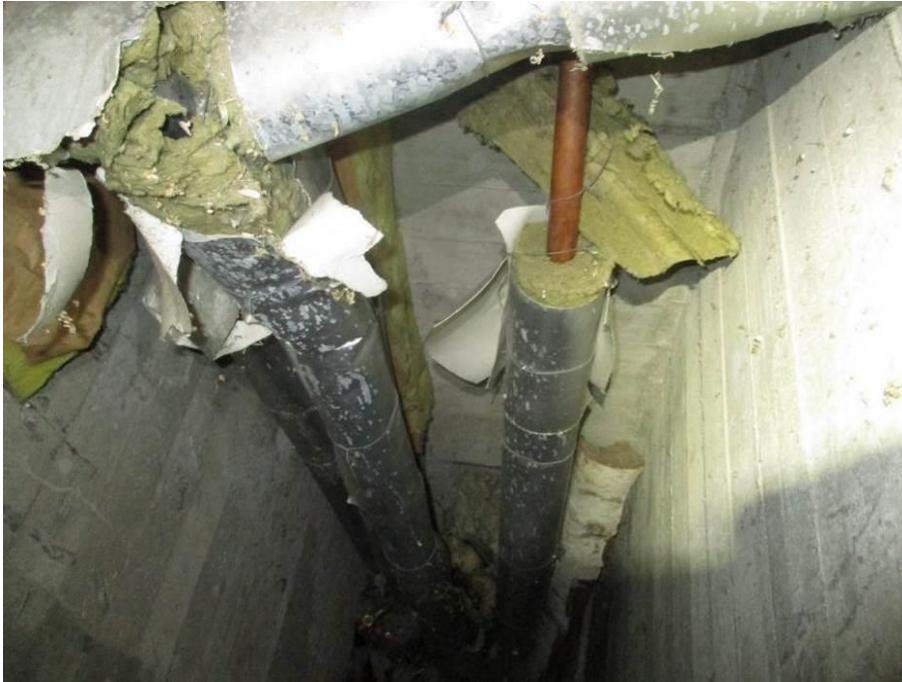
Kuva 152. Vanhan koulurakennuksen teknisen työn luokkaan tuleva kanaali
