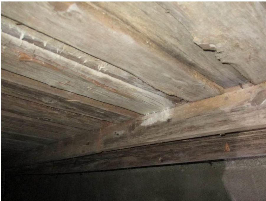
Kuva 33. Puurakenteissa mikrobikasvua.
