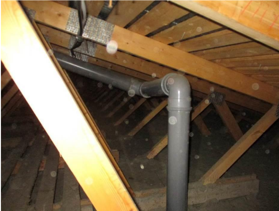
Kuva 89. Viemärin tuuletusputki.
