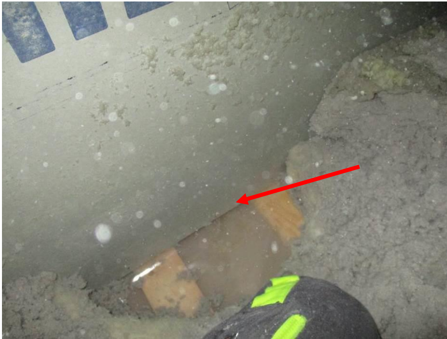
Kuva 93. Liikuntasalin ja varaston välinen katon saumakohta.
