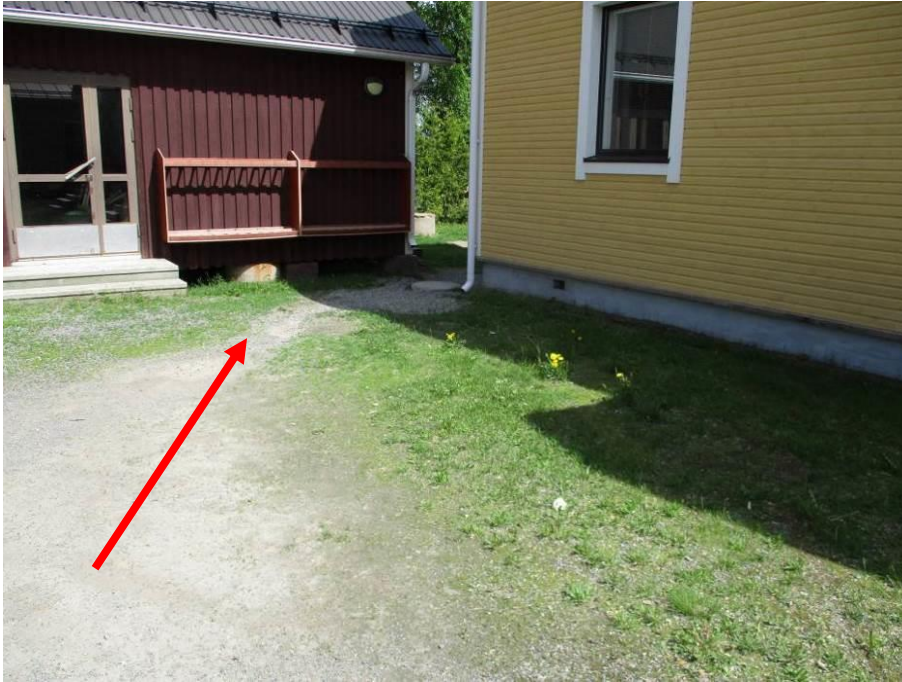
Kuva 8. Sisäpihan pintavedet ohjautuvat päädyn kautta jokeen.
