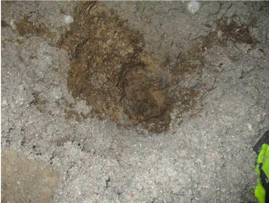
Kuva 79. Puhallusvillan alla on sammal.
