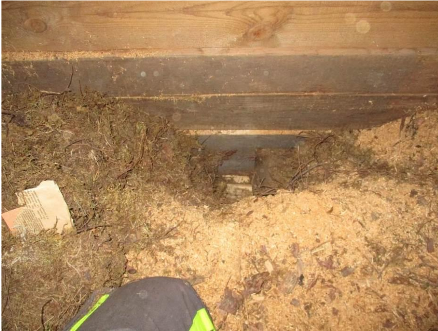
Kuva 77. Yläpohjassa sammaleristys.
