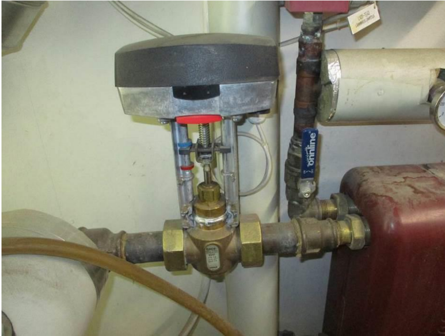
Kuva 149. Säätömoottori
