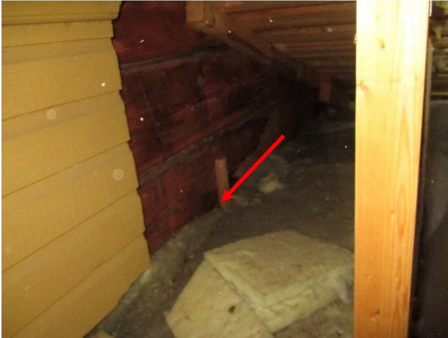
Kuva 85. Vanhan ja uuden osan liittymäkohta.
