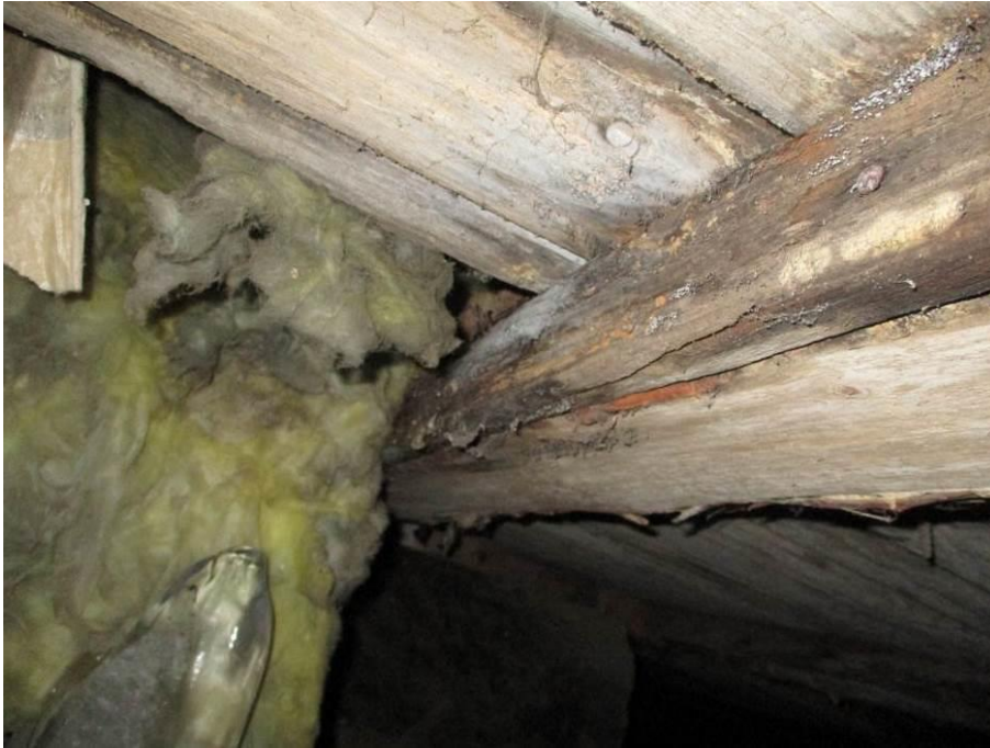
Kuva 36. Puurakenteissa lahovaurioita.
