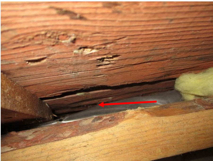
Kuva 86. Uuden osan yläpohjan höyrynsulkumuovi on kiinni vanhan osan hirsiseinässä.
