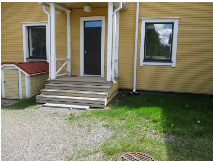
Kuva 15. Kuistin kattovedet johdetaan rakennuksen vierustalle.
