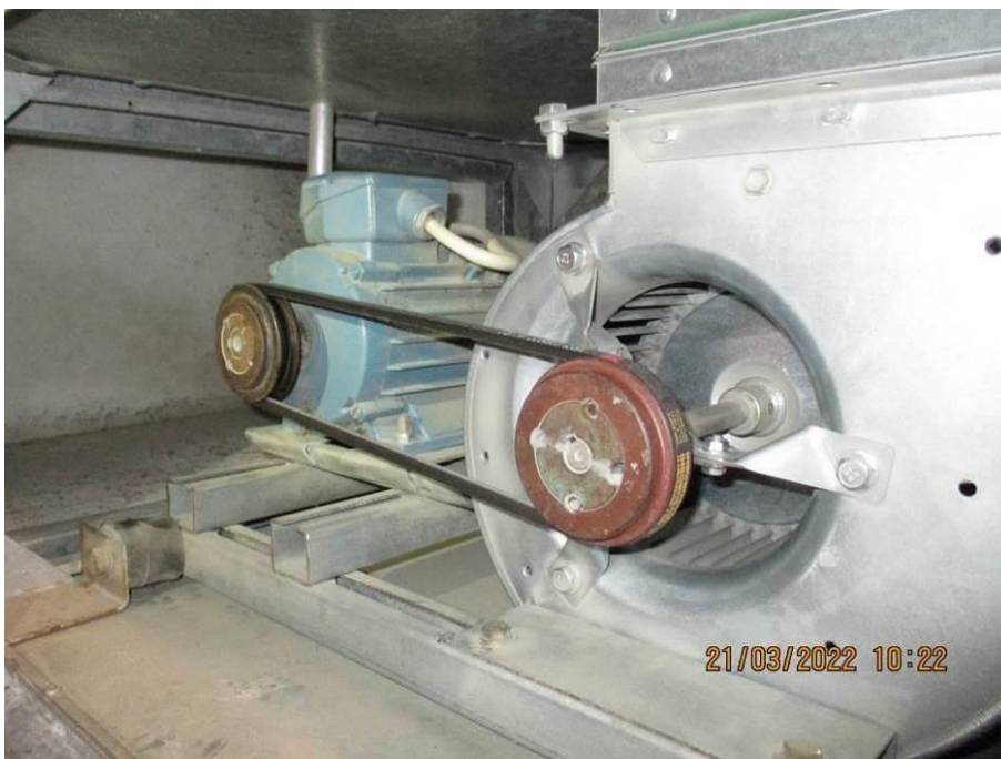
Kuva 169. Poistoilmapuhallin
