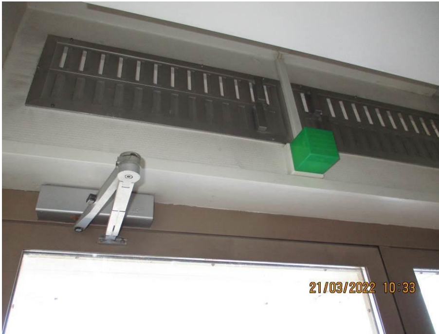
Kuva 172. Korvausilmasäleikkö eskarin tiloissa
