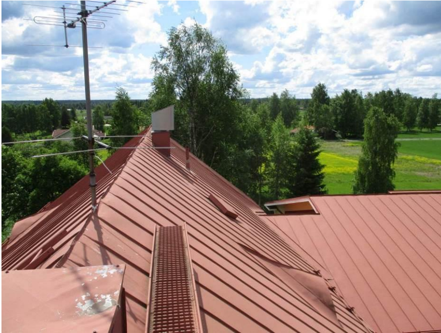
Kuva 72. Laajennuksen vastaharja.
