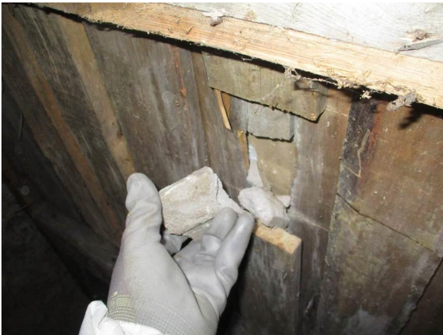
Kuva 31. Alapohjassa ohut betonivalu.
