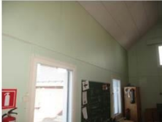
Kuva 1. Asbestikuitusementtilevyä.
