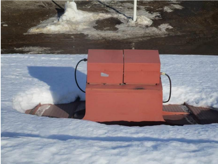
Kuva 170. Huippuimurit PF05 ja PF06
