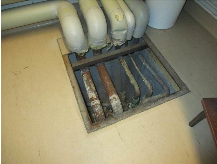
Kuva 154. Laajennusosalle tuleva putkistokanaali
