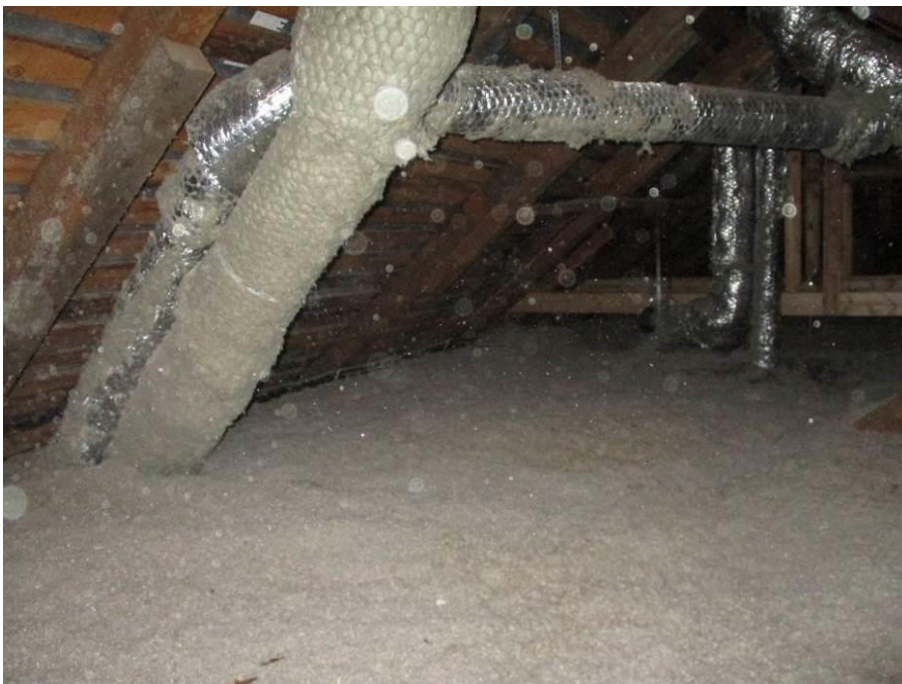
Kuva 78. 2. kerroksen luokkahuoneen yläpohjassa puhallusvilla eristeenä.
