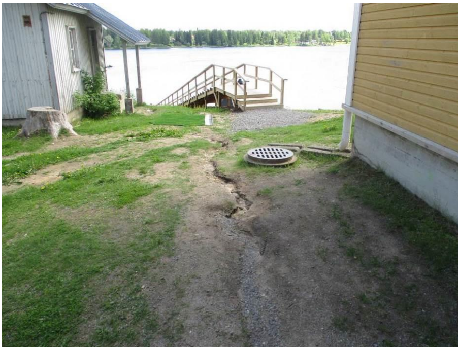
Kuva 3. Maanpinnassa pintaveden valuman myötä tullut uoma.
