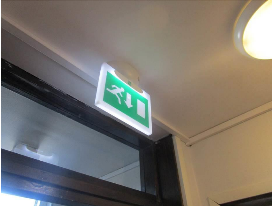
Kuva 188. Uusittu turvavalaisin
