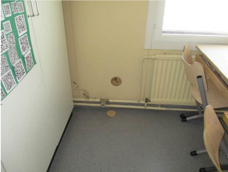
Kuva 51. Ulkoseinän rakenneavaus.
