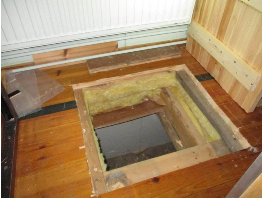
Kuva 40. Alapohjan kulkuluukku.
