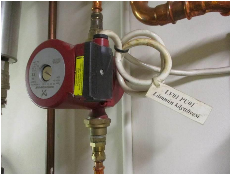
Kuva 146. Kiertovesipumppu
