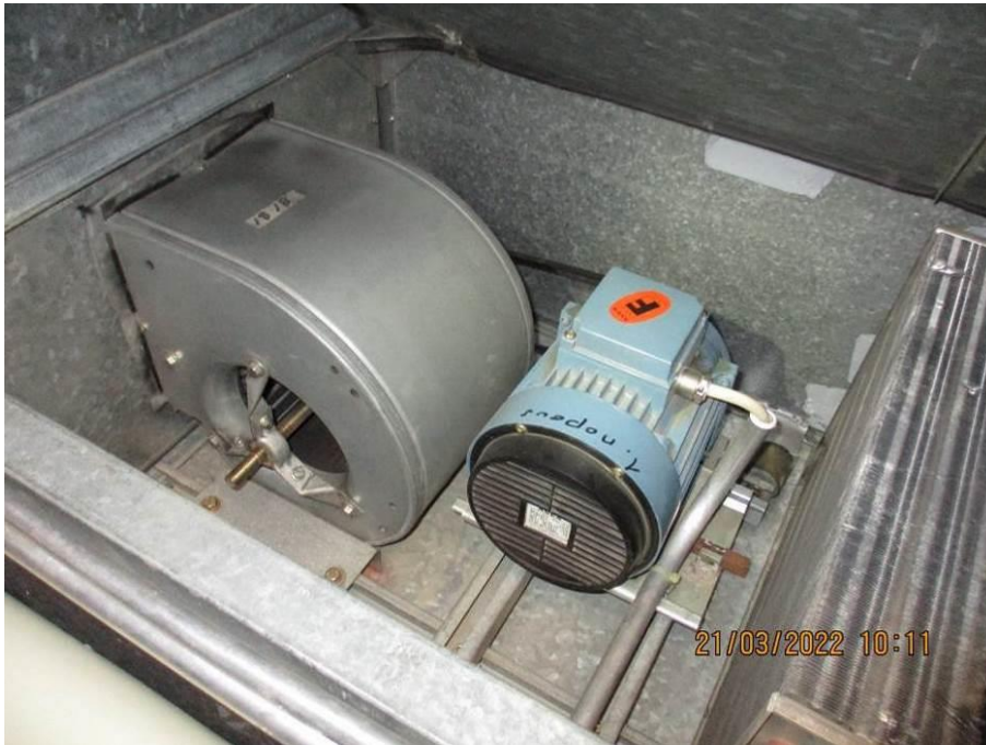
Kuva 168. Tuloilmapuhallin
