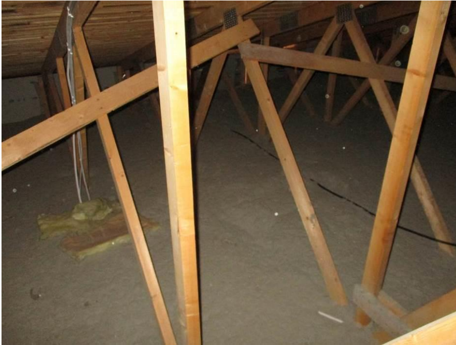
Kuva 87. Yleiskuva laajennusosan yläpohjasta.
