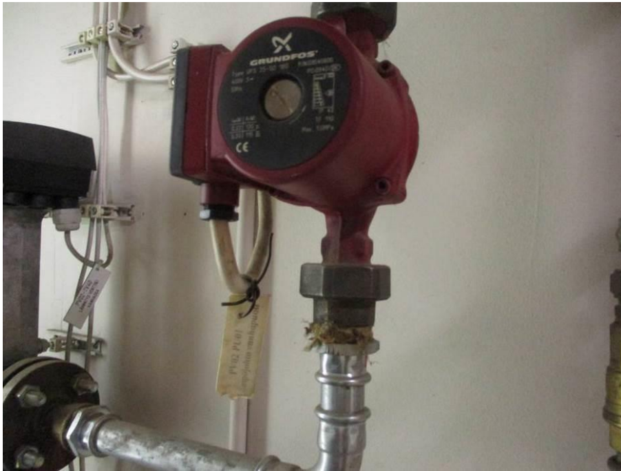
Kuva 147. Kierto-vesipumppu
