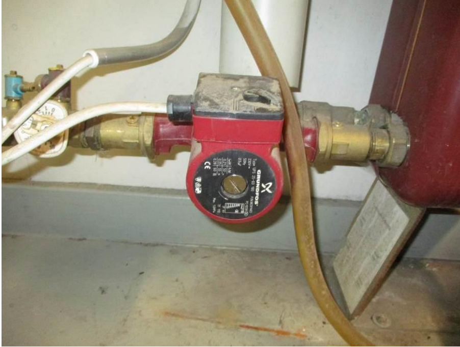
Kuva 145. Kiertovesipumppu
