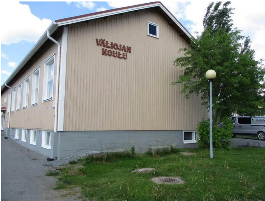
Kuva 48. Alkuperäisen osan julkisivu.
