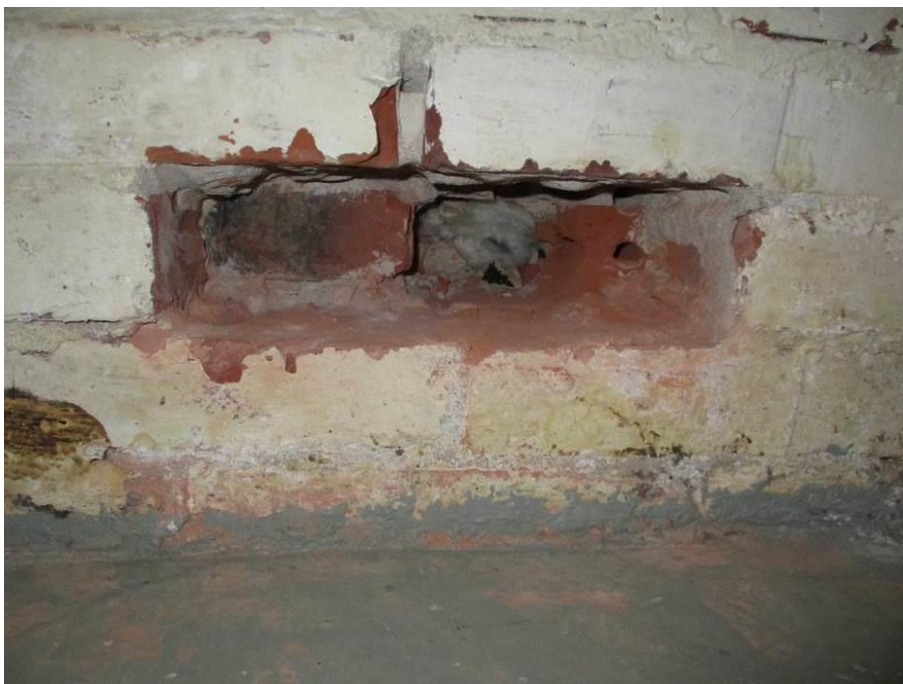
Kuva 32. Seinässä kaksi tiiltä rinnakkain.
