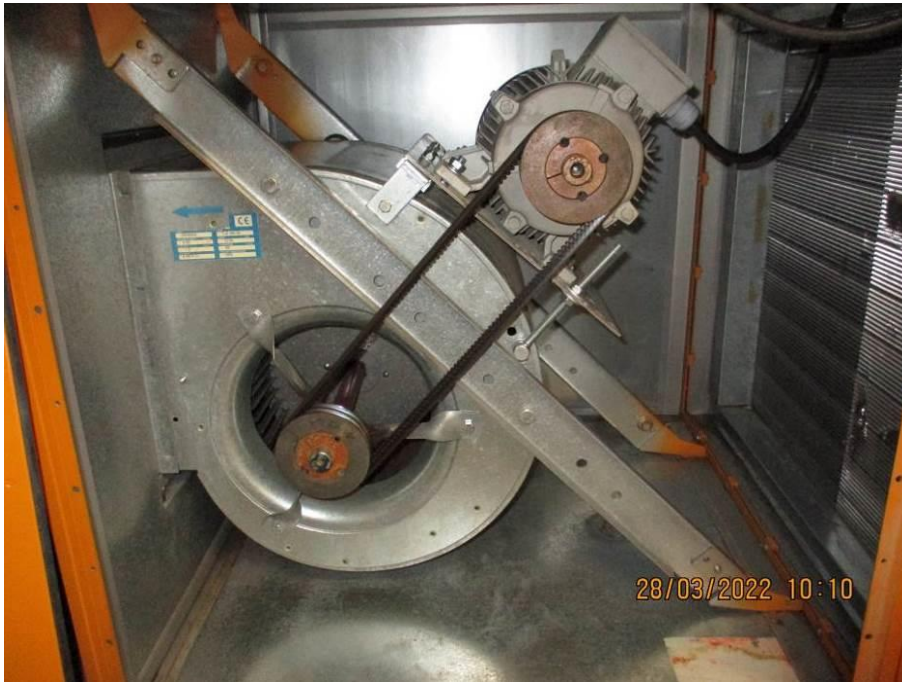
Kuva 149. Tuloilmapuhallin
