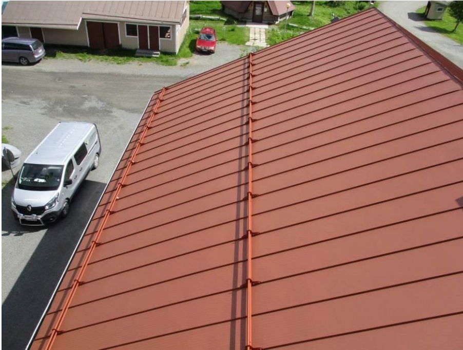
Kuva 63. Vesikattovarusteet ovat asianmukaiset.
