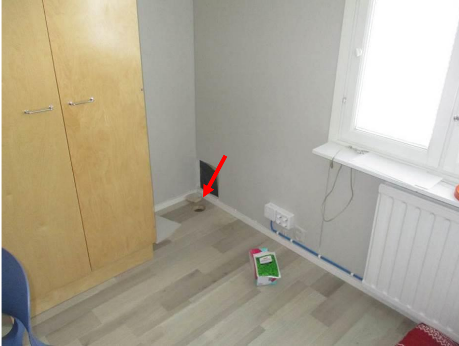
Kuva 28. 2. kerroksen välipohjan avaus.
