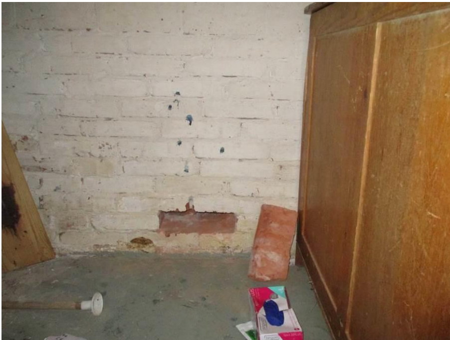
Kuva 31. Varaston seinän avaus.
