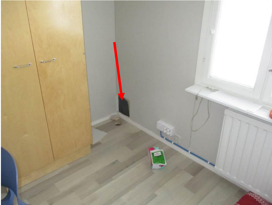
Kuva 42. 2. kerroksen ulkoseinän rakenneavaus.
