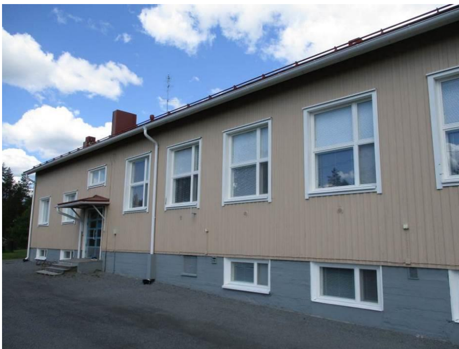
Kuva 49. Julkisivu on ehyt alkuperäisessä osassa.
