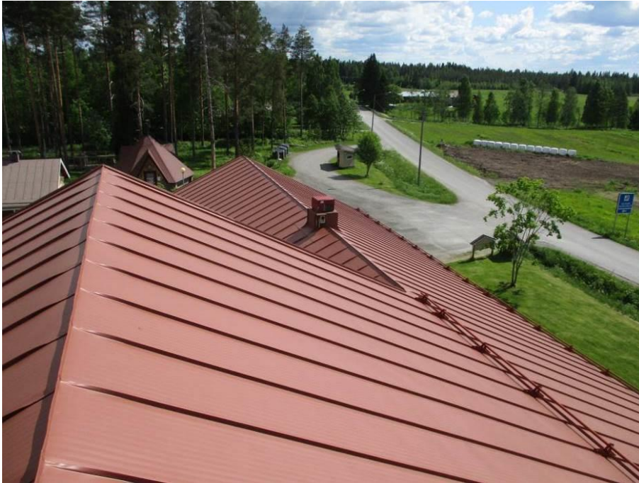
Kuva 56. Alkuperäisen osan vesikatto.
