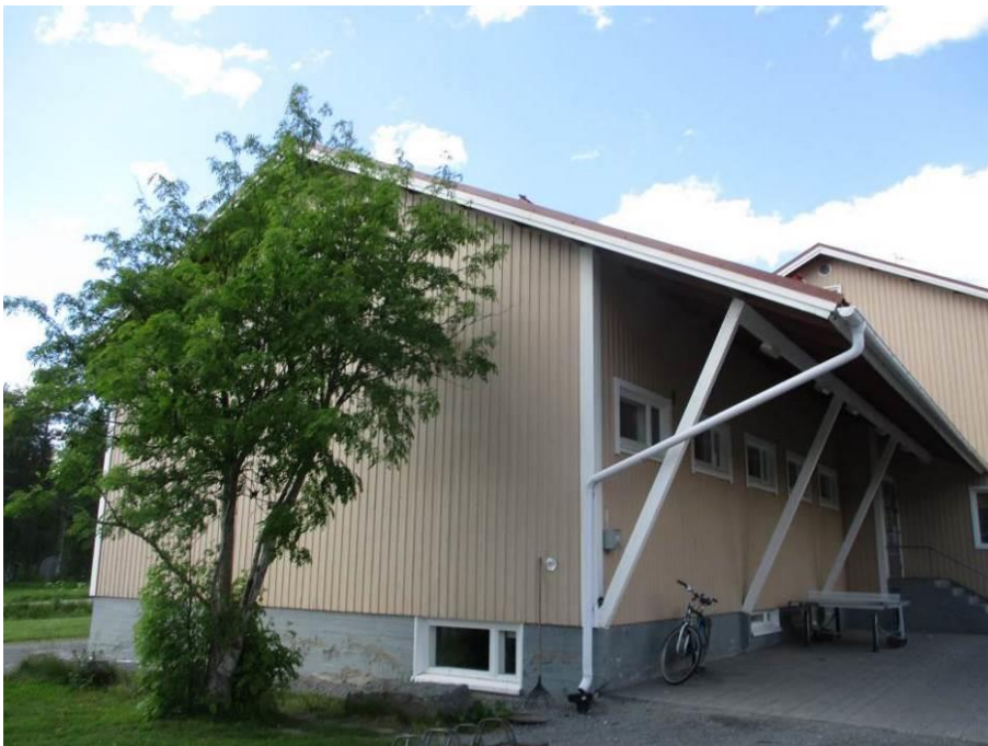
Kuva 9. Vanhan osan sisäänkäynti.
