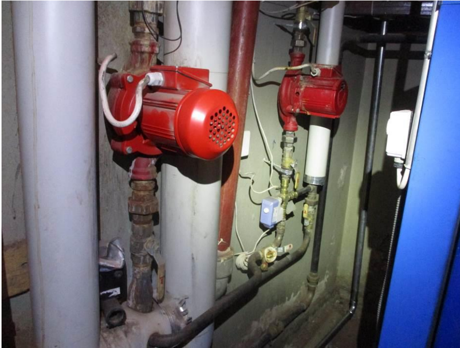
Kuva 133. Kiertovesipumppuja
