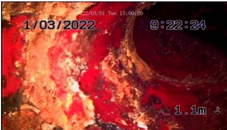
Kuva 142. Kuvaus 3., uusittu viemäriputki keittiöltä.
