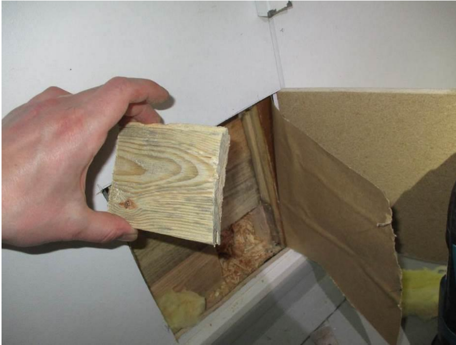
Kuva 36. Vaakalaudoituksen pinnassa on hieman tummumaa.
