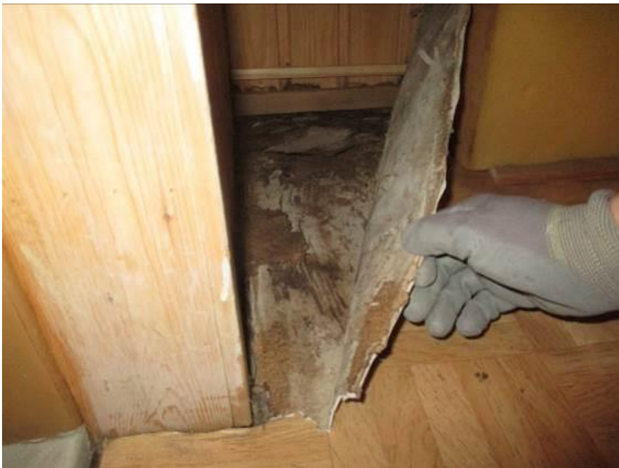
Kuva 111. Lattia kosteusvaurioitunut
