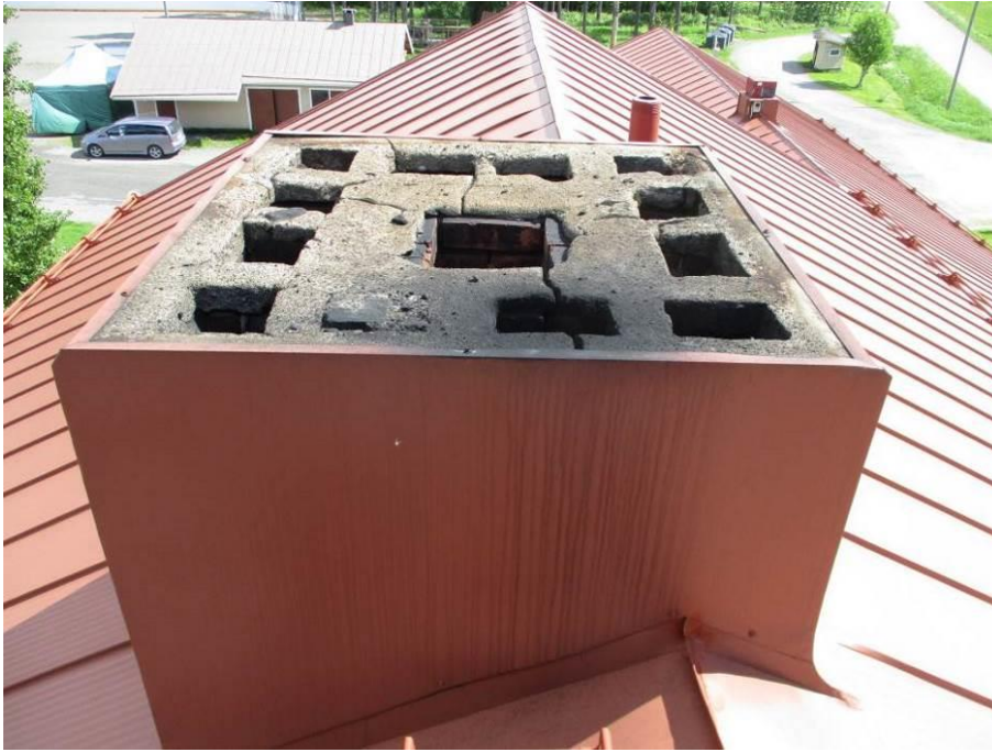
Kuva 57. Piipun päällä ei ole hattua.
