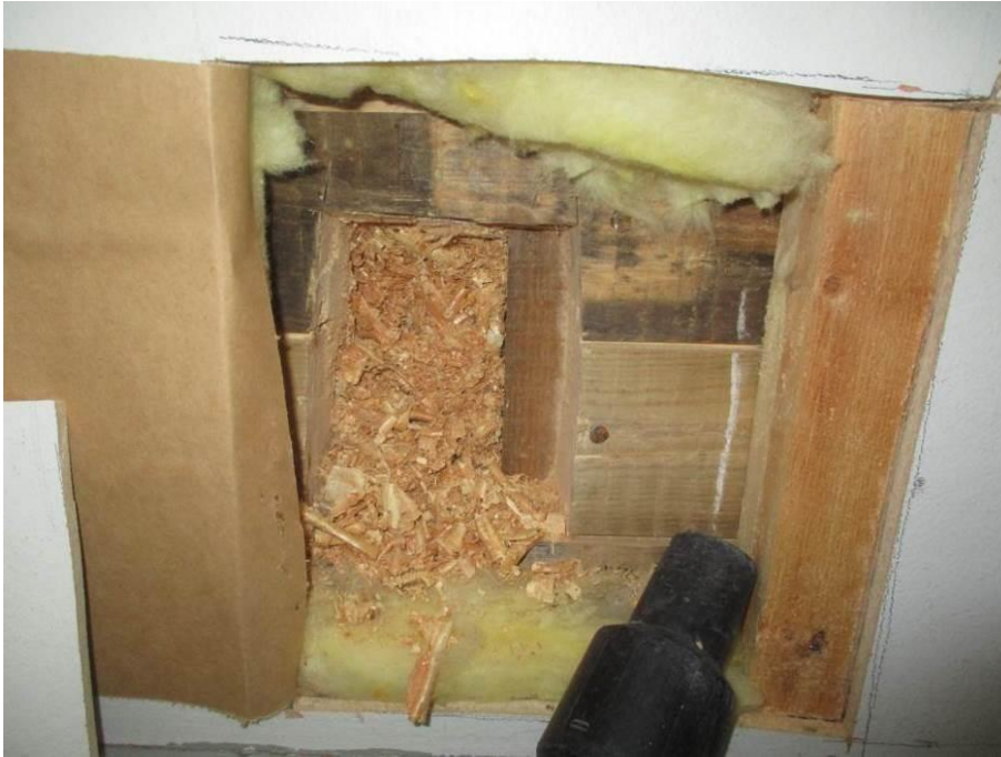
Kuva 38. Takapihan ulkoseinän rakenneavaus.
