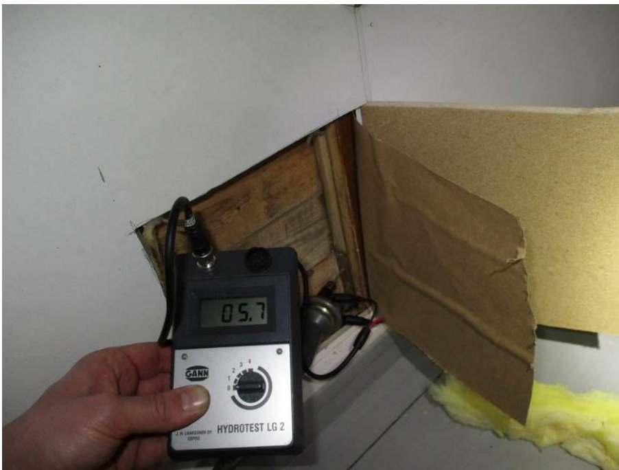
Kuva 37. Laudoituksen kosteus on normaali.
