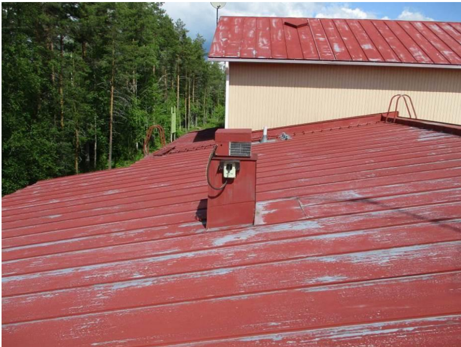
Kuva 152. PF-2 laajennusosan luokat
