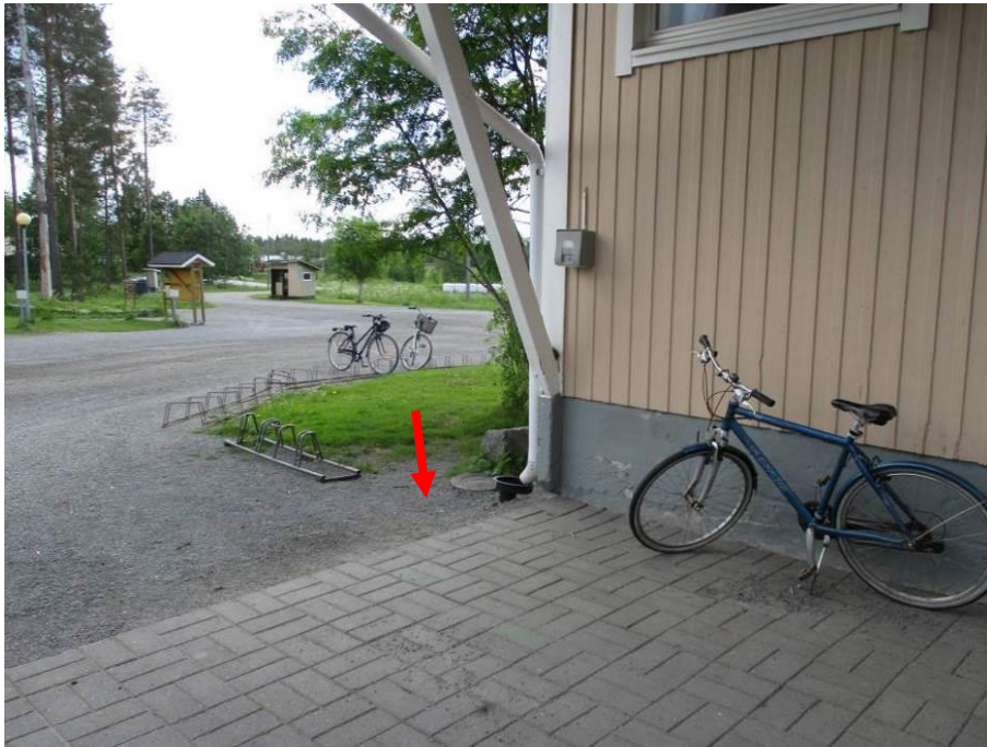
Kuva 15. Kellarin salaojan tarkistuskaivo.
