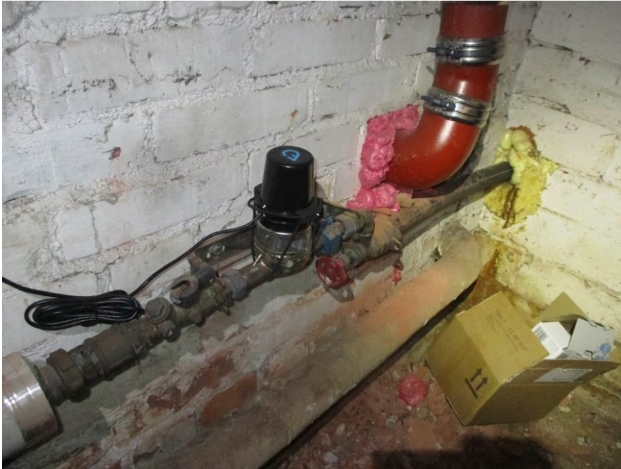
Kuva 137. Päävesimittari
