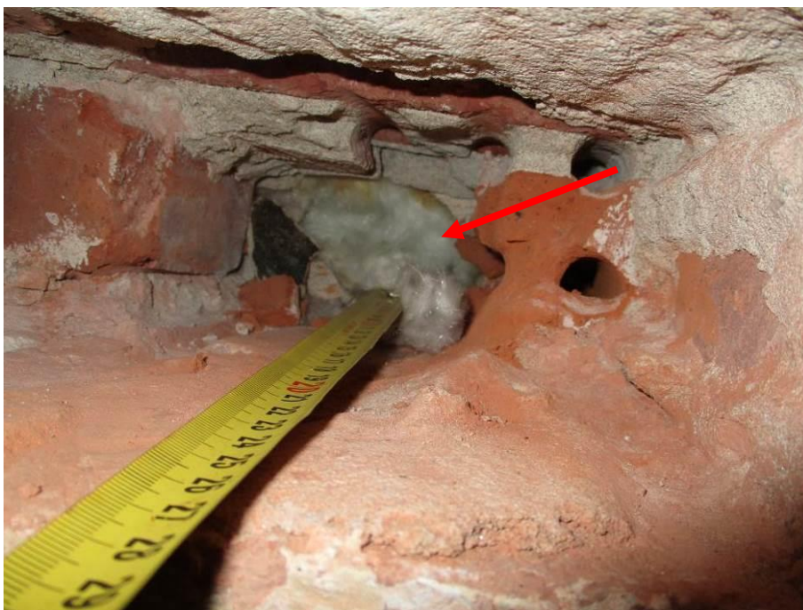
Kuva 33. Tiilikuoren taustalla mineraalivillaa.
