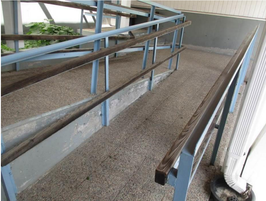
Kuva 8. Maalipinta hilseilee.
