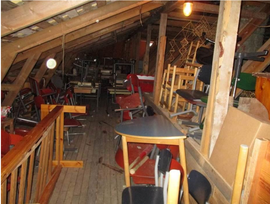
Kuva 64. 1. kerroksen yläpohja alkuperäisessä osassa.
