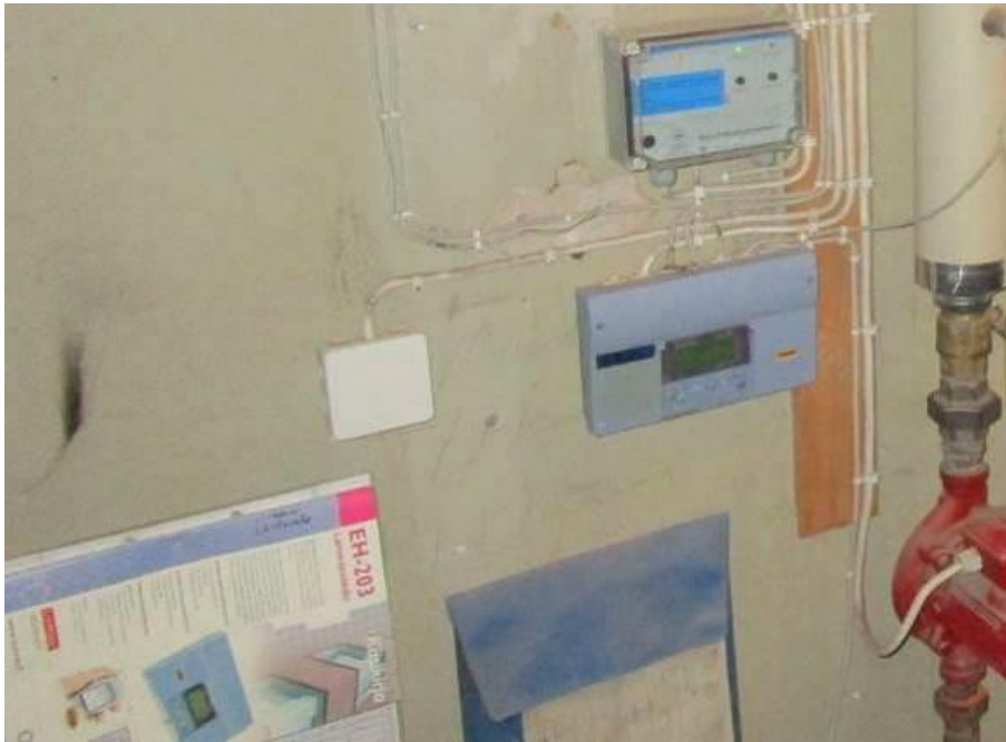
Kuva 169. Lämmitysjärjestelmän yksikkösäädin
