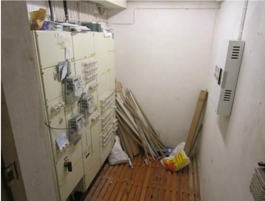
Kuva 120. Sähköpääkeskus
