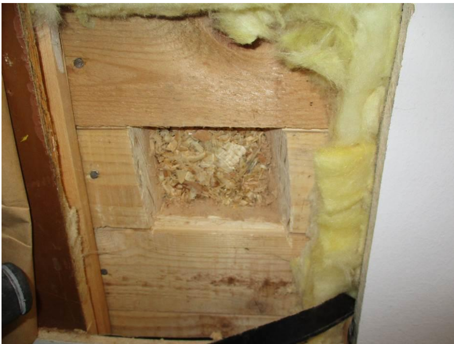
Kuva 41. Alkuperäinen purueristys.
