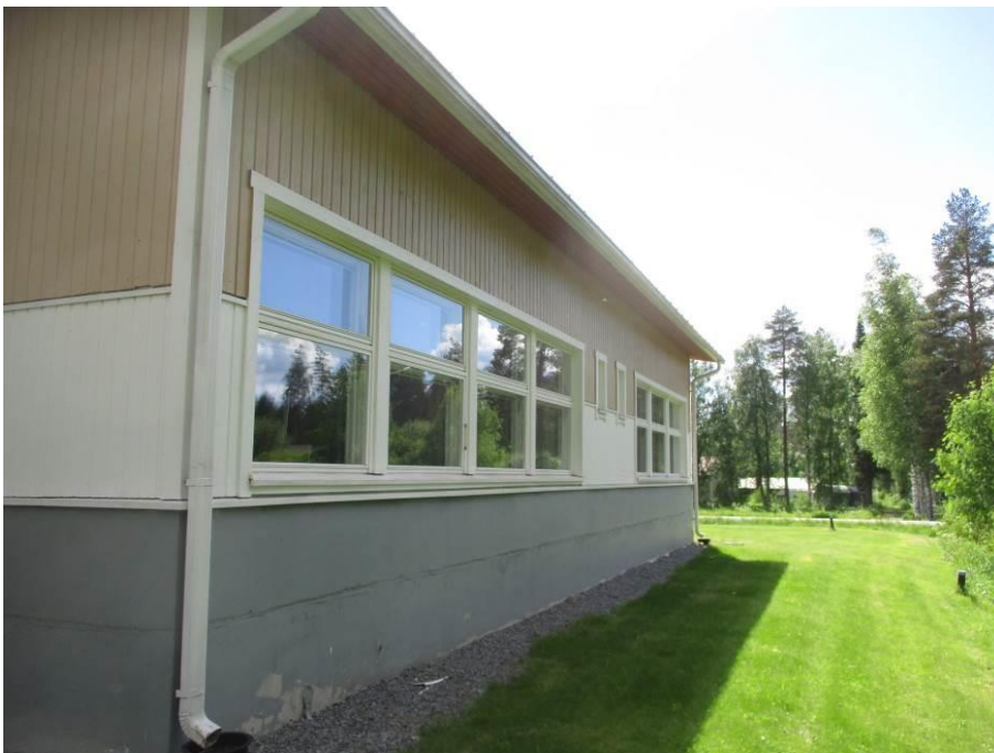
Kuva 51. MSK- ikkunat.
