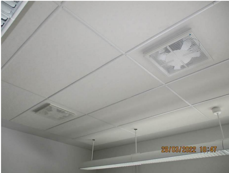
Kuva 156. Tuloilmanpätelaitteita katossa
