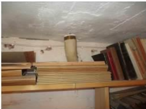
Kuva 5. Asbestipitoista putkieristettä.
