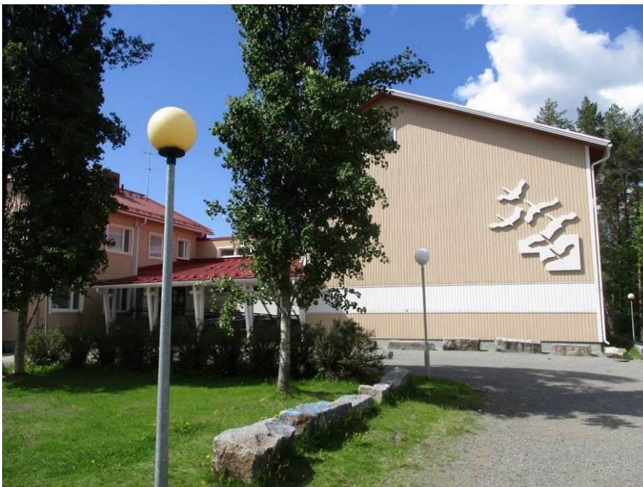
Kuva 45. Yleiskuva liikuntasalin päädystä.
