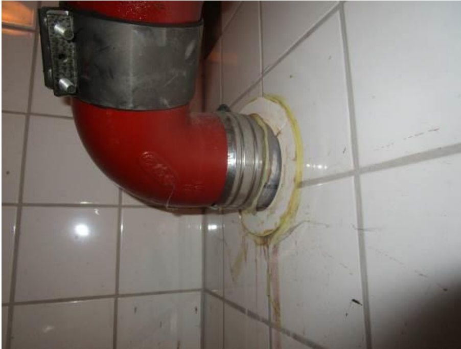
Kuva 143. Pantaliitos vuotaa hieman
