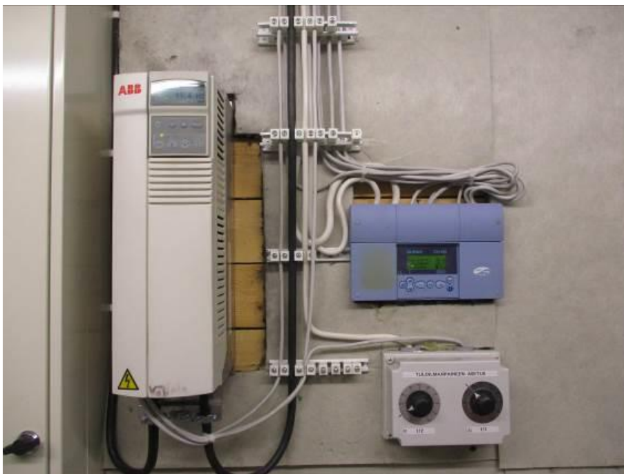
Kuva 170. Ilmanvaihdon yksikkösäädin
