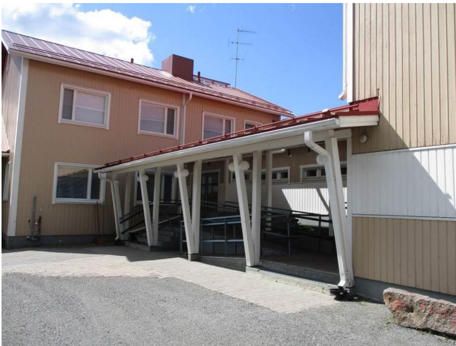
Kuva 5. Betonilaatoitus pääsisäänkäynnin edustalla.
