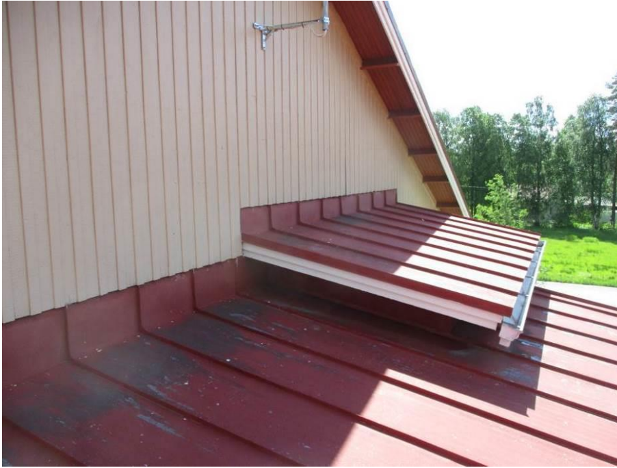
Kuva 59. 2. kerroksen tuuletusparvekkeen vesikatto.
