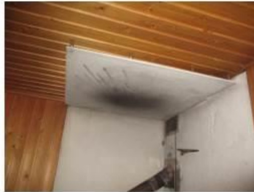
Kuva 4. Kiukaan päällä oleva asbestikuitusementtilevy.
