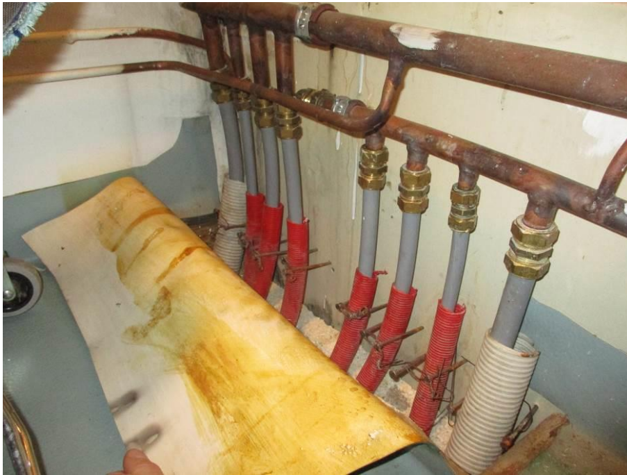
Kuva 138. Keittiön käyttövesiputket
