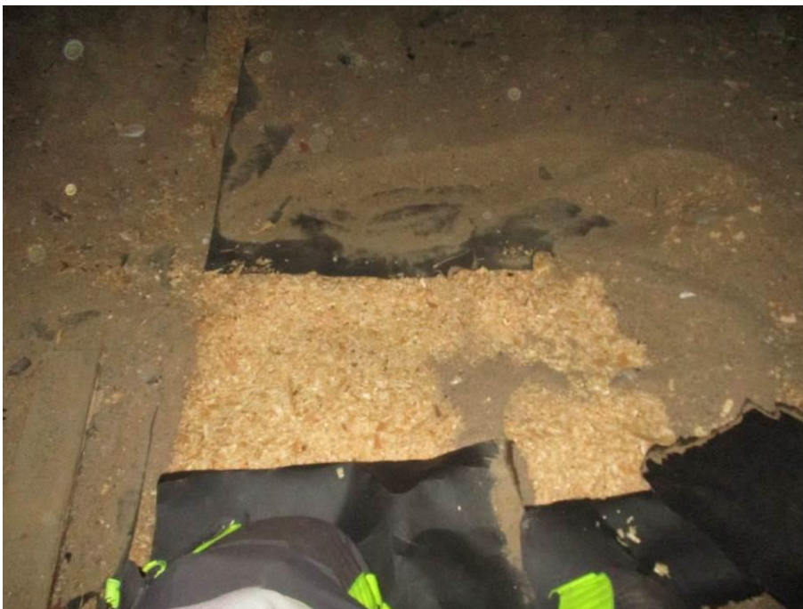
Kuva 65. Yläpohjassa purueristys, tervapaperi ja hiekka.
