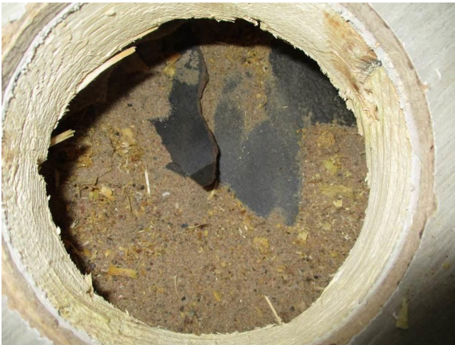
Kuva 29. Välipohjassa on hiekkaa ja tervapaperi.
