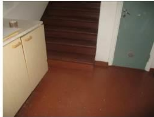
Kuva 8. Lyijyä sisältävä punainen lattiamaaali.
