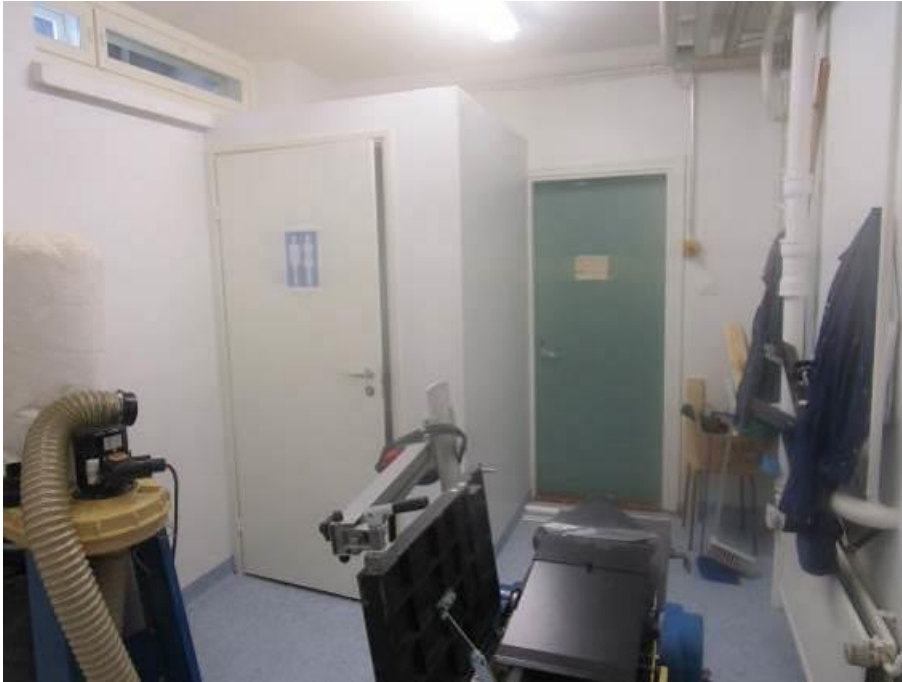
Kuva 116. Pesuhuone ja wc-tila
