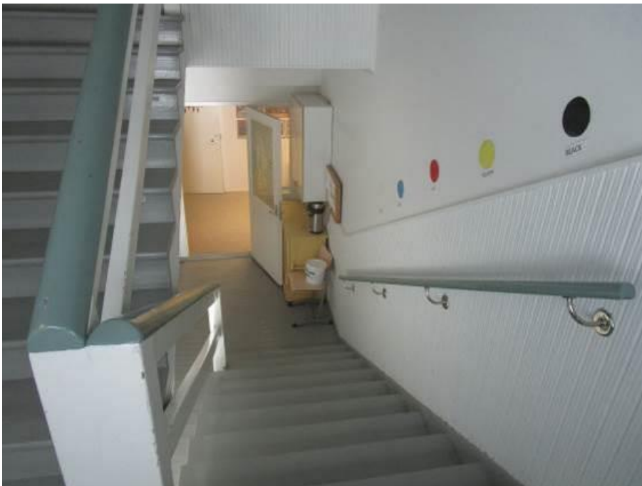
Kuva 104. 2. kerrokseen johtava porrashuone
