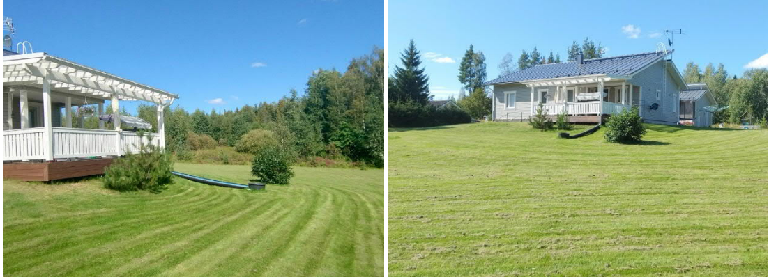
Kuva 3. (vas.) Suunnittelualueen piha-alue ja sitä ympäröivää metsää. Kuva 4. (oik.) Suunnittelualueella sijaitsee vuonna 2013 valmistunut omakotitalo (Kuvat: maanomistaja, 2023).
