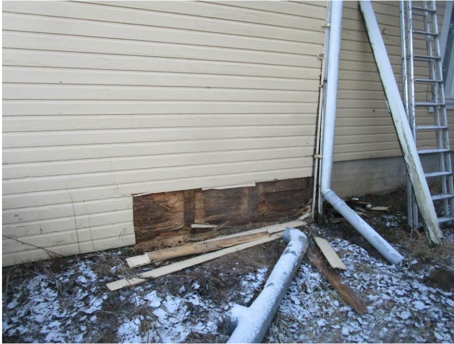
Kuva 31. Ulkoseinän avaus pitkältä sivulta.
