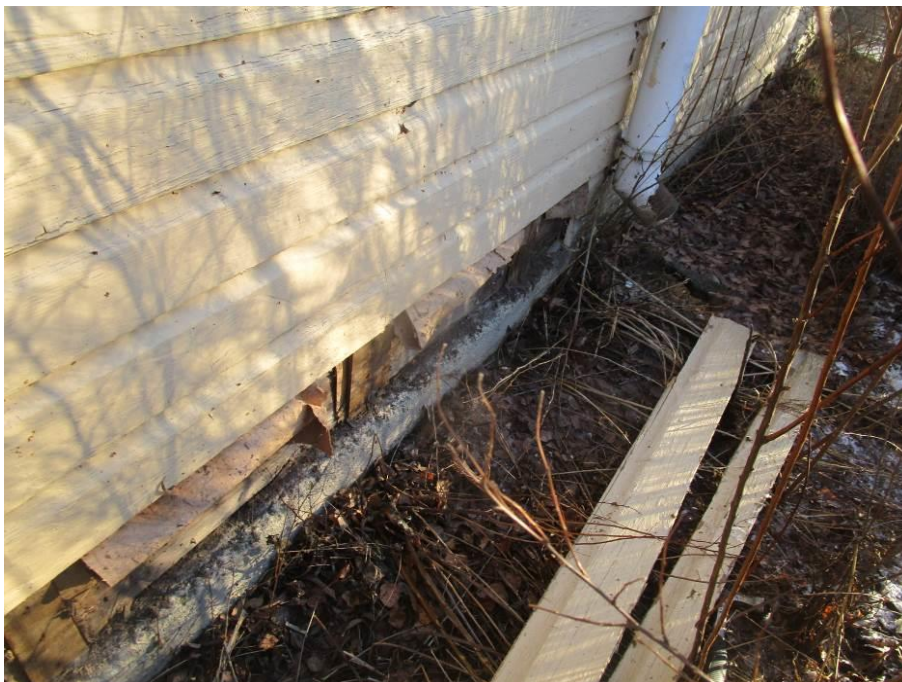
Kuva 16. Paneeli tausta tarkastettiin paneelit poistamalla.
