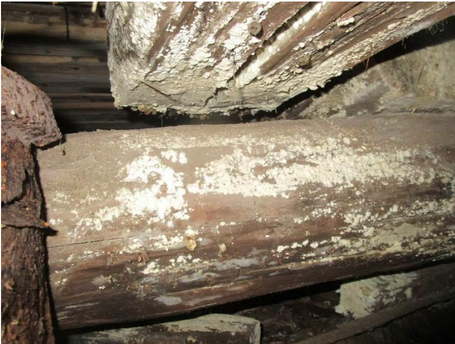
Kuva 9. Palkeissa voimakas mikrobikasvu.
