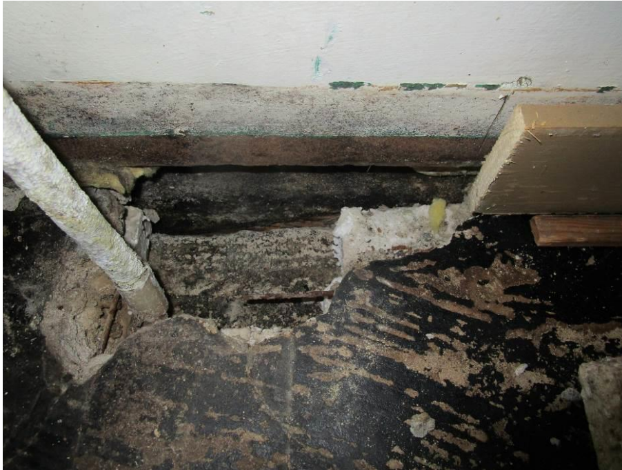
Kuva 35. Yleiskuva seinän alaosa.
