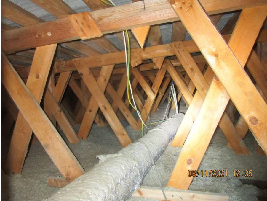
Kuva 38. Yleiskuva laajennuksen yläpohjasta.
