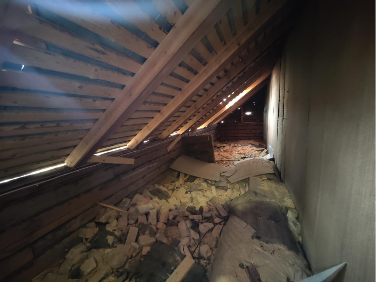
Kuva 4. Yleisnäkymää ullakolla. Ullakolta on suora yhteys ulos katon rakojen kautta. Alareunassa näkyy rakennustarvikkeita.
