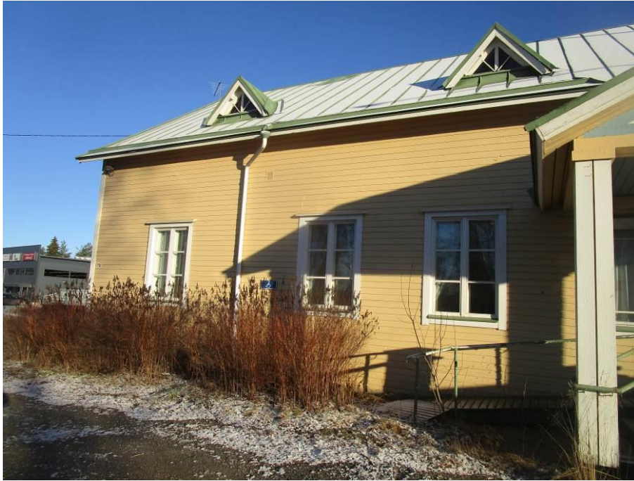
Kuva 15. Ulkoseinän vasen pääty.
