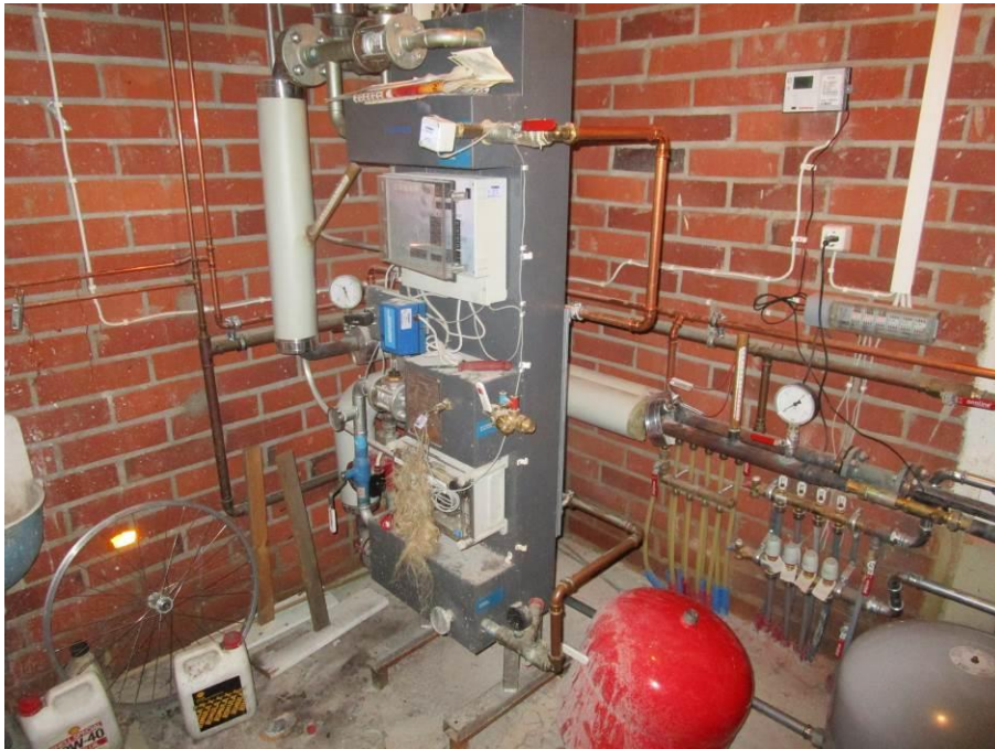
Kuva 44. Lämmönsiirtimet
