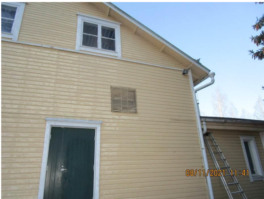
Kuva 61. Tuloilmakoneen raitisilmasäleikkö
