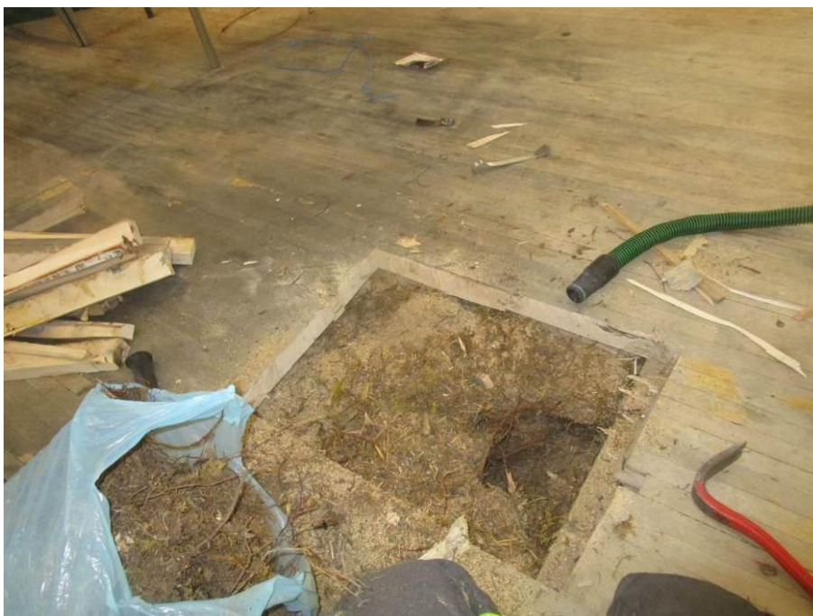
Kuva 2. Salin lattian rakenneavaus.
