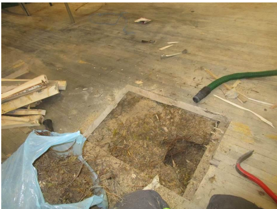
Kuva 2. Salin lattian rakenneavaus.
