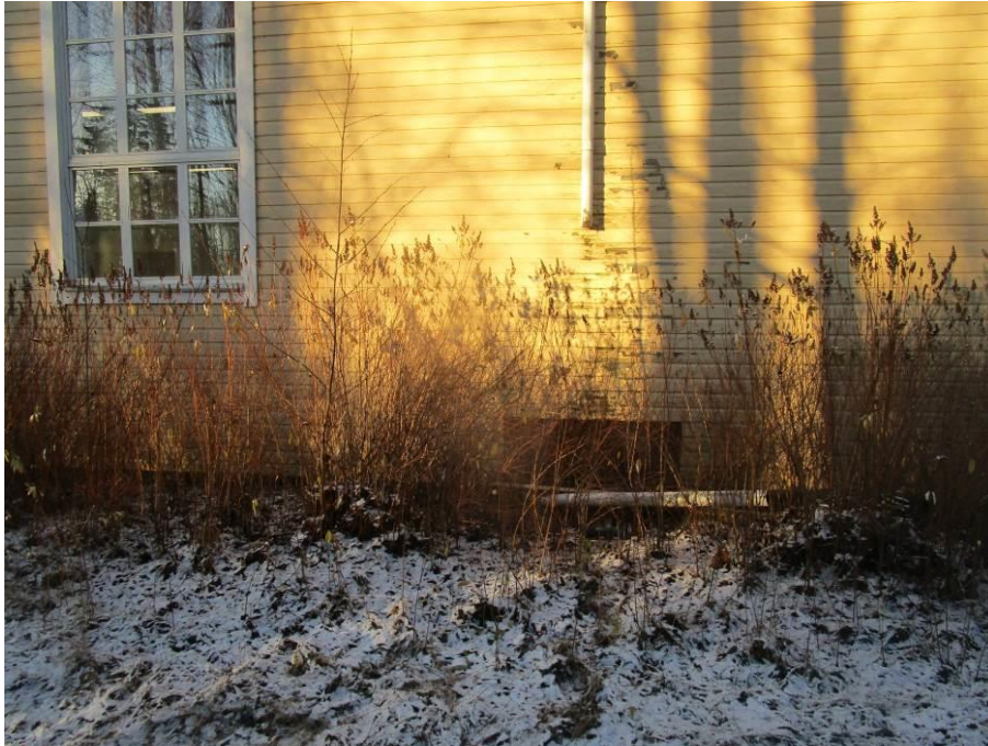
Kuva 24. Seinä avattiin myös toisen syöksytorven alta.
