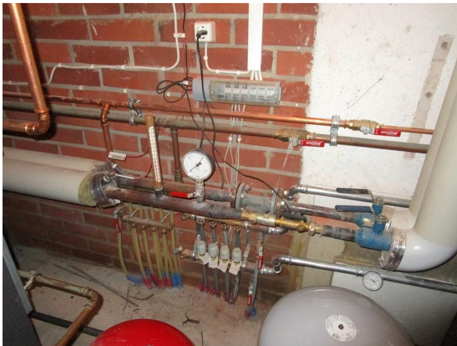
Kuva 49. Laajennusosan jakotukit
