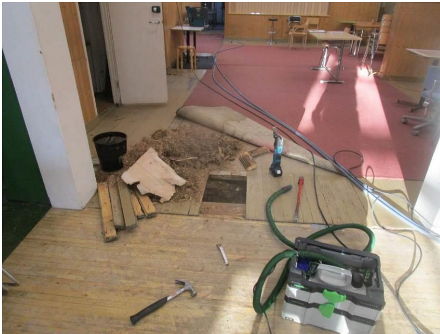
Kuva 7. Rakenneavaus aulasta.
