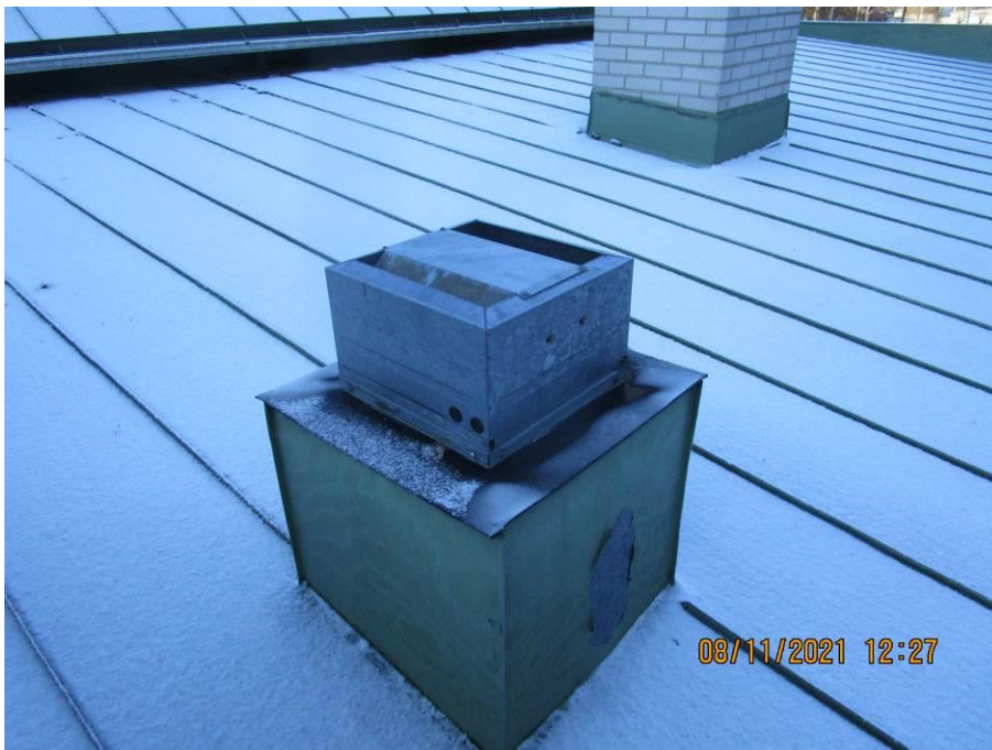
Kuva 63. Pienempi huippuimuri
