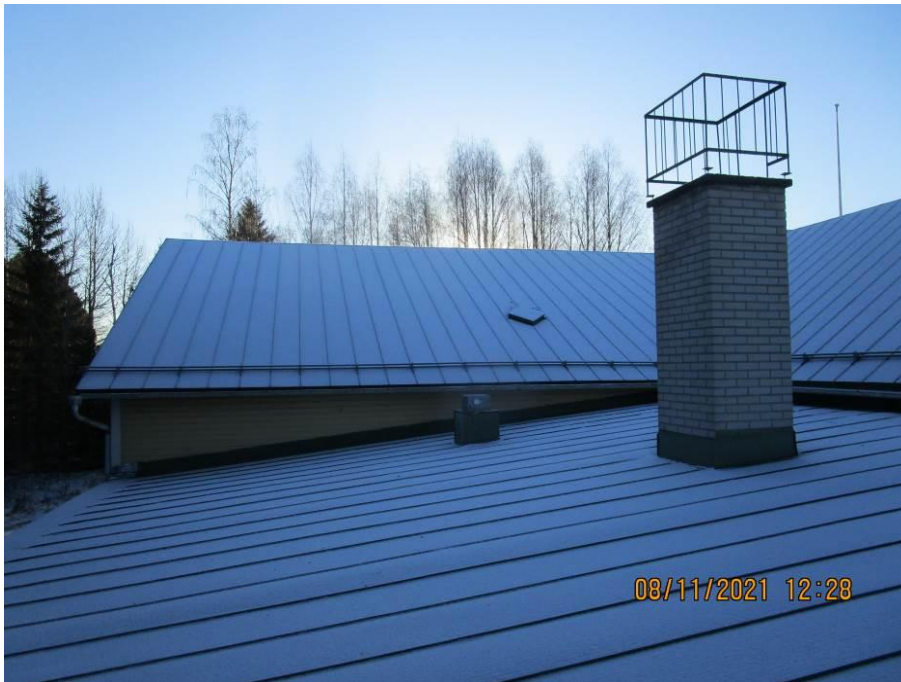
Kuva 37. Yleiskuva laajennuksen vesikatosta.
