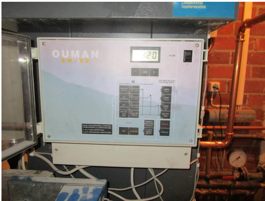
Kuva 48. Yksikkösäädin
