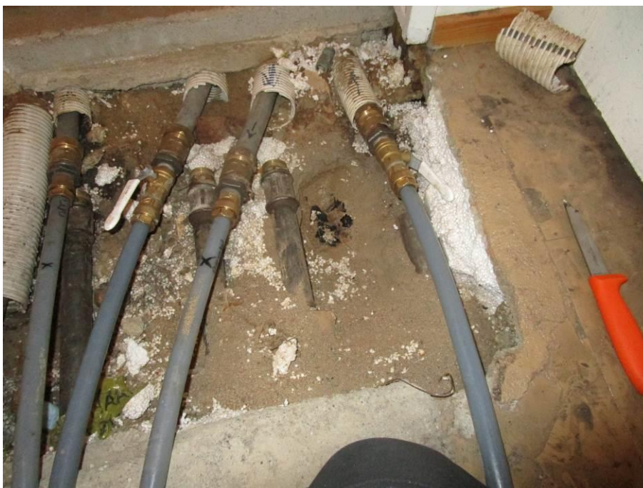
Kuva 13. LVI-putkistojen tarkastuskaivo
