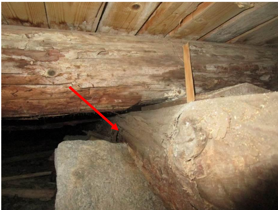
Kuva 6. Kivi on painunut lahon myötä puun sisälle.
