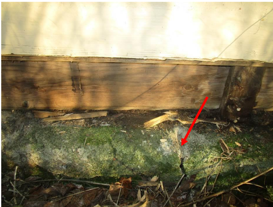
Kuva 20. Sokkeli on halki.
