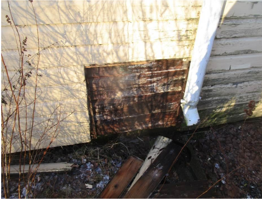
Kuva 22. Syökytorven taustalla hirsirunko on märkä.
