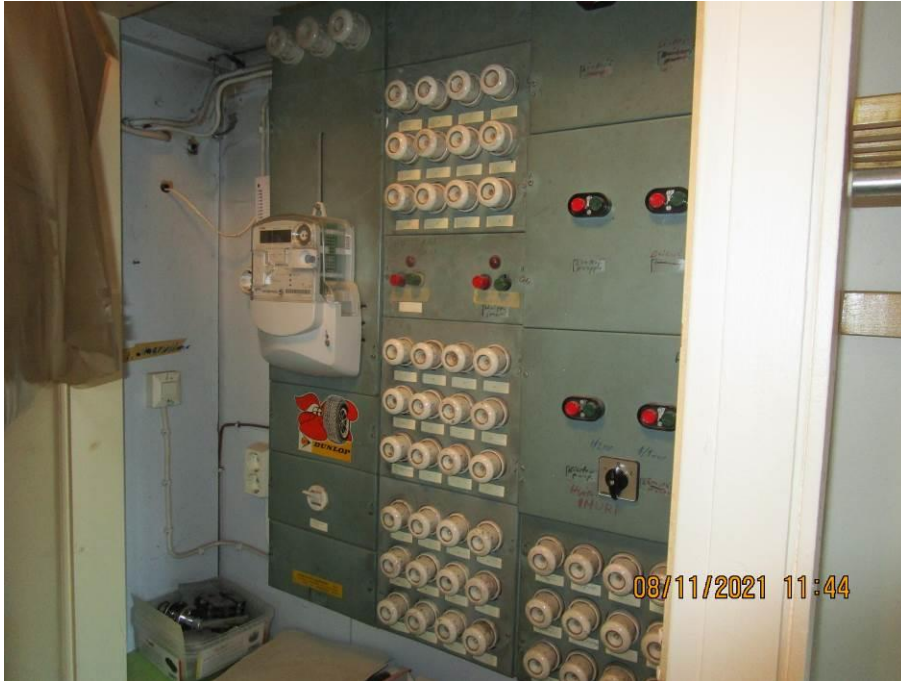
Kuva 67. Sähköpääkeskus
