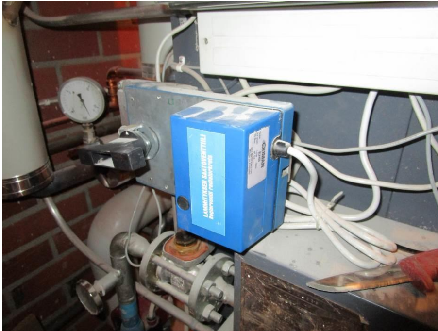
Kuva 47. Säätöventtiili
