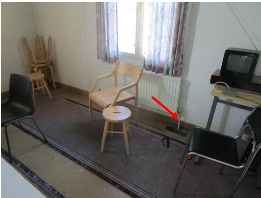
Kuva 34. Ulkoseinä avattiin myös sisäkautta.
