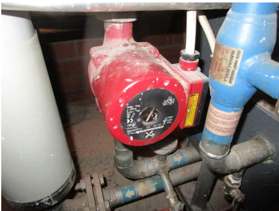
Kuva 45. Kiertovesipumppu
