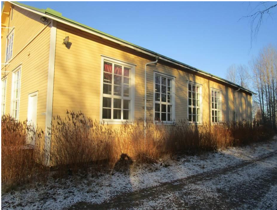
Kuva 21. Yleiskuva oikeanpuoleisesta päädyistä.
