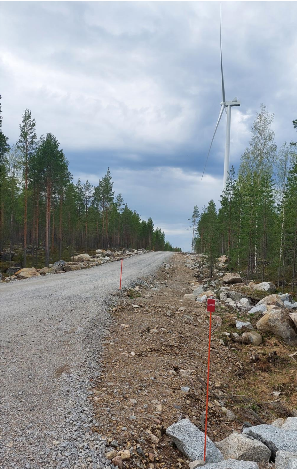
Kuva 18. Esimerkki tuulivoimapuiston rakennus- ja huoltotiestä. Maakaapelin oja on sijoitettu tien oikealle puolelle ja merkitty maastoon viitoin (Ilosjoen tuulipuisto, Pihtipudas). Teitä käytetään muun muassa betonin ja soran sekä voimaloiden komponenttien kuljetuksiin. Tuulivoimapuiston käyttövaiheessa teitä käytetään mm. vuosittaisissa huolloissa.
