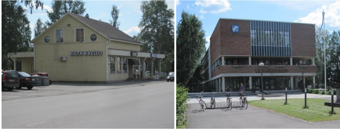
Kuva 5 Maakunnallisesti arvokkaat rakennukset Kirkkokatu 6 ja Haapajärven kaupungintalo.
