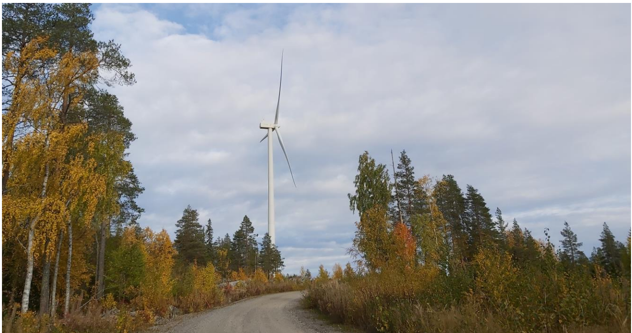
Kuva 48. Tuulivoimaloiden rakentaminen ja huoltotoimenpiteet edellyttävät tieverkkoa ja tilaa kunkin turbiinin ympärille.
